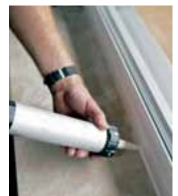
Abschließend werden die Anschlüsse des neuen Fensters ausgefugt.
