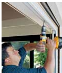
Der innere Rahmen des neuen Fensters wird aufgesetzt und montiert.
