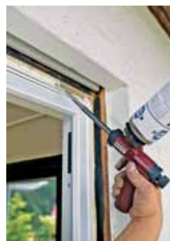
Nach dem Ausschäumen wird dann der äußere Kunststoffrahmen gesetzt.
