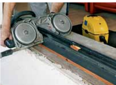
Die Spezialsäge mit Staubabsaugung nimmt zwei Drittel des alten Rahmens ab.
