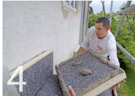
4 ... kommen jeweils noch zusätzlich zwei Kleberbatzen auf die Plattenrückseiten, dann ...
