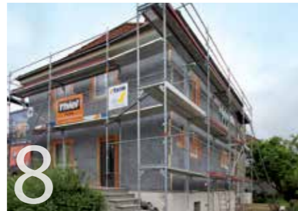
8 Schließlich ist das Haus komplett mit den Dalmatinerplatten eingepackt.
