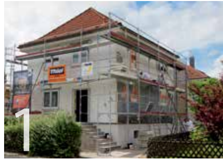
1 Das gesamte Haus wird für die Fassadenarbeiten vorschriftsmäßig eingüstert.
