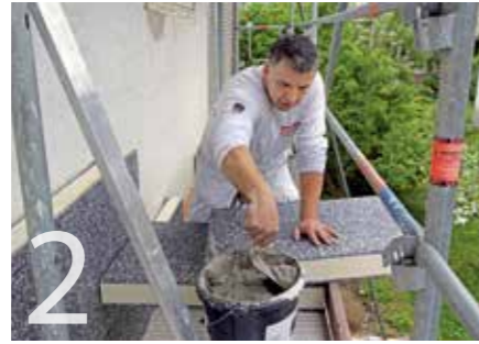
2 Der auf die Dämmplatten genau abgestimmte Klebemörtel wird angemischt und ...
