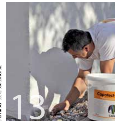
13 Der Sockelbereich wird mit einem speziellen Abdichtungsanstrich geschützt.
