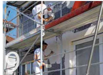
9 Dann wird der Spachtel mit Carbonfaserverstärkung auf die Wände aufgezogen.
