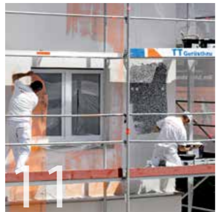
11 ... anschließend noch einmal mit derselben Carbonfaserspachtelung überzogen.
