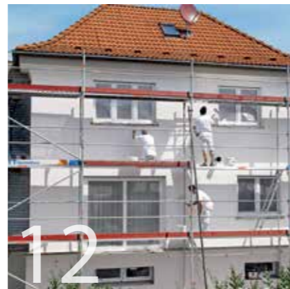
12 Erst wird grundiert, dann nach Trocknung kann die Fassadenfarbe aufgerollt werden.
