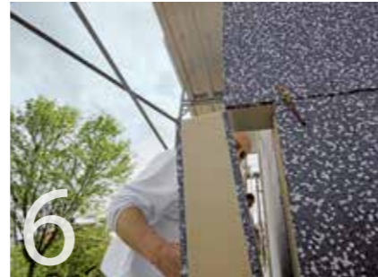
6 An den Ecken werden die Plattenreihen im Wechsel miteinander verzahnt.
