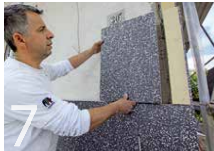
7 Durch den Einsatz von Plattenabschnitten werden Kreuzfugen in der Fläche vermieden.
