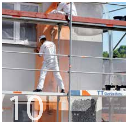
10 In den frischen Armierungsspachtel wird ein Armierungsgewebe eingelegt und ...
