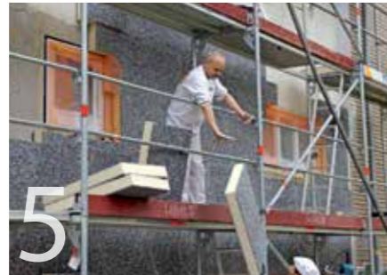
5 ... werden sie auf den alten Putz geklebt und später auch noch mit Dübeln gesichert.
