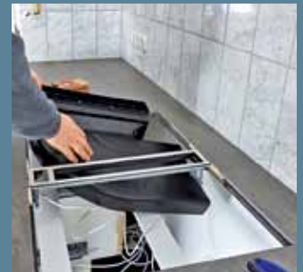
H. Dann wird das flache Verbind- ungskanalelement eingebaut.
