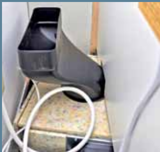
E. Oben sitzt der Anschlussstutzen für die Anbindung ans Kochfeld.
