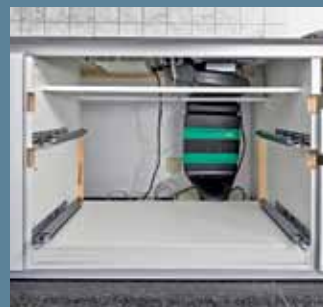
J. So sieht das Ganze aus nach Ein- bau des Abzugkanalsystems.
