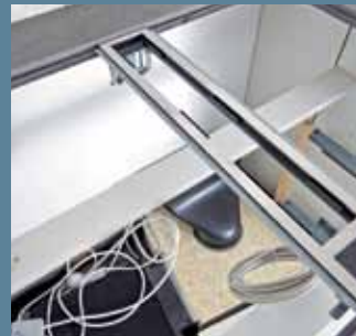
F. Die Abzugschiene sitzt mittig zwischen den Kochfeldern und ...
