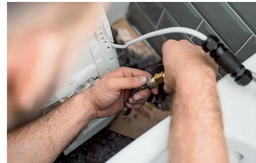
**10** Jetzt verbindet der Installateur noch den Strom- beziehungsweise Wasseranschluss mit dem Technischelement des Dusch WC-Aufsatzes ...
