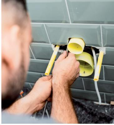
**2** Durch das Leerrohr im Montageelement wird der Wasserschlauch bis zum Wasseranschluss im Spülkasten geführt und ...
