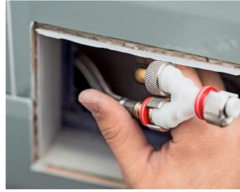
**3** ... hier an ein Y-Stück angeschlossen (Wasser für Spülung bzw. Duschfunktion). Dieses dann ans Eckventil anschließen.
