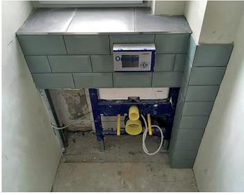
**1** Hinter der Wand ist ein neuer Unterputzpülkasten mit Strom- und Wasseranschluss für das Dusch-WC installiert.
