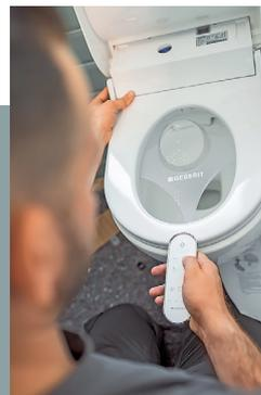
**13** Ebenso nimmt der Installateur die Zuweisung der Fernbedienung vor und testet deren Funktion - alles unter einem schützenden Klarsichtdeckel.
