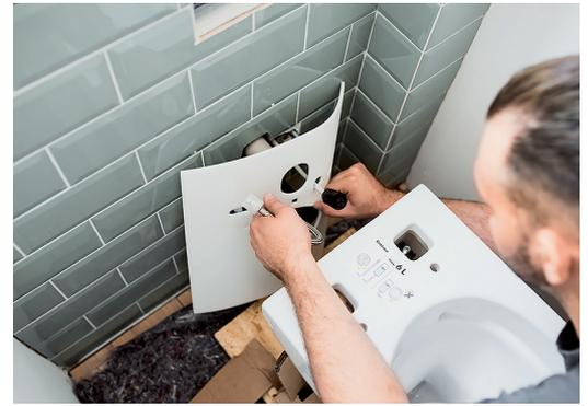
**7** Zwischen Wand und WC werden die Schallschutzmatte angebracht sowie die beiden Leitungen durchgeführt.
