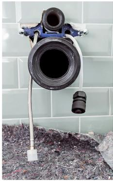
**6** Nun sind alle Anschlüsse für das Dusch-WC vorbereitet. Links der Wasserschlauch, rechts der Stromanschluss.
