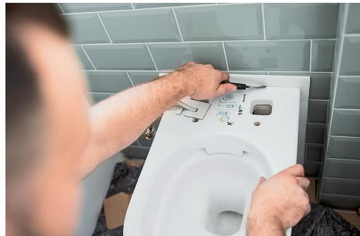
**9** ... und kann so leicht über die Trag-Gewindestangen bis zur Wand geschoben werden. Sitzt das WC dann fest, werden die Überstände der Schallschutzmatte abgeschnitten.
