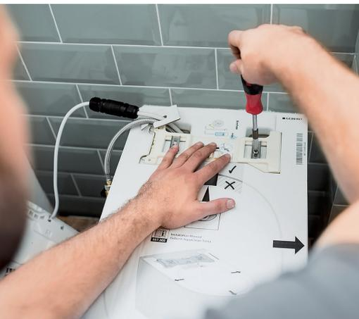
**11** ... und schraubt die Montageplatte, die zur Befestigung des Aufsatzes dient, auf die WC-Keramik und richtet sie mit einer Schablone aus.
