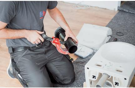
**5** Dann werden Spülrohr und Abflusstutzen auf die nötige Länge gekürzt und am Montageelement eingesteckt.
