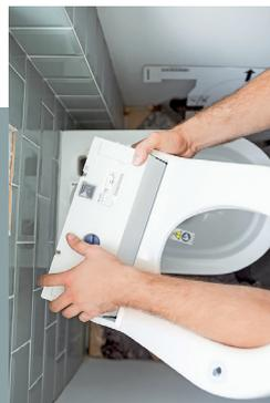
**12** Und dann wird der Dusch-WC-Aufsatz an der Montageplatte befestigt. Es folgt die Inbetriebnahme und Prüfung der Dusch- und Komfortfunktionen.
