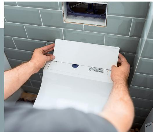
**14** Wenn alles passt, wird die Designabdeckung auf die technische Einheit aufgesetzt. Sie harmonisiert optimal mit der WC-Betätigungsplatte.
