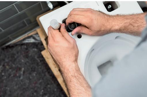
**8** Wasser- und Stromanschluss führt der Installateur durch die entsprechende Öffnung in der WC-Keramik. Das WC steht auf der Verpackung ...
