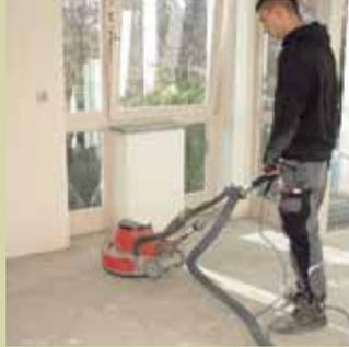
Zur besseren Haftung des späteren Spachtelauftrags wird dann der Estrich leicht angeschliffen.
