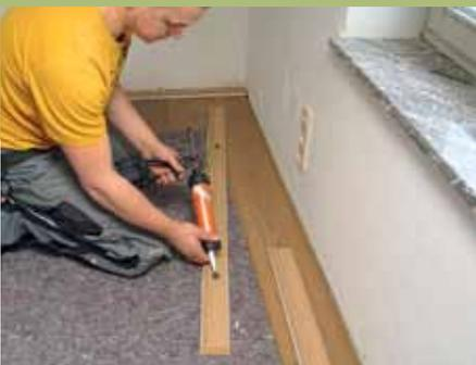
**19.** Die weiß (RAL 9010) lackierten MDF-Sockelleisten werden im Punktklebeverfahren mit Silikon an die Wand geklebt.
