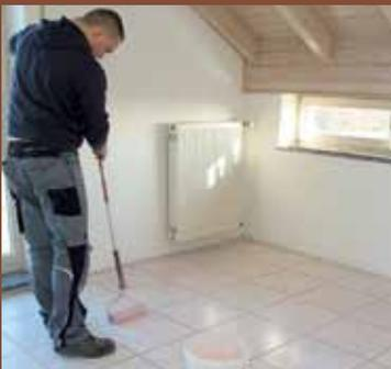
... mittels Walze in einer Schichtdicke von 150-250g/m<sup>2</sup> vollflächig auf die Fliesen aufgetragen wird.
