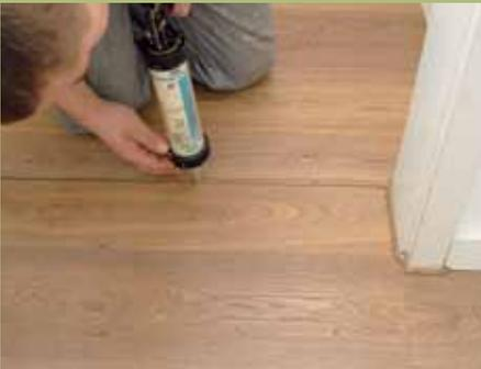
**17.** Dehnungsfugen (wie hier mit farbigem Silikon ausgeführt) sind bei über mehrere Räume laufenden Böden unumgänglich.
