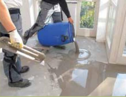
**7.** Auch in den Räumen mit entferntem Altbodenbelag wird auf den Bestandsestrich die Spachtelmasse aufgebracht.
