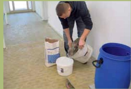
1. Nach 24 Stunden Trocknungszeit wird mit klarem Wasser eine standfeste, kunstharzvergütete Spachtelmasse angerührt, mit der ...
