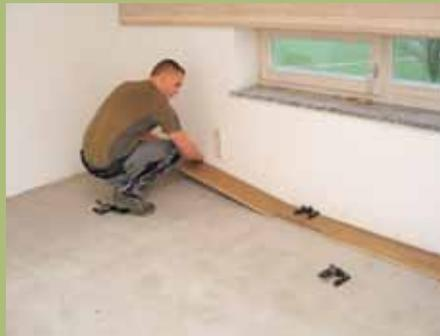
**11. ... Anschlusskante zu erhalten, werden die 195 mm breiten Dielen mittels Abstandhalter fluchtgerecht ausgerichtet ...**
