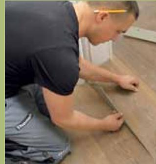
**15.** ... deren exakte Breite erst durch die erste Reihe der Flurwanddielen definiert werden kann.
