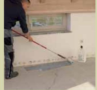
Die Grundierung dient als Haftbrücke für den späteren vollflächigen Spachtelauftrag.
