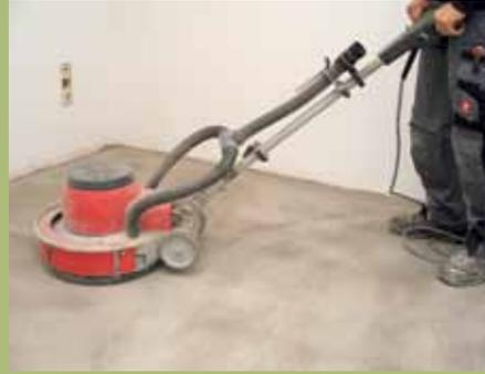
**8.** Für eine optimale Haftung des Klebstoffs wird nach 24 Stunden der nun verlegereife Untergrund leicht angeschliffen.
