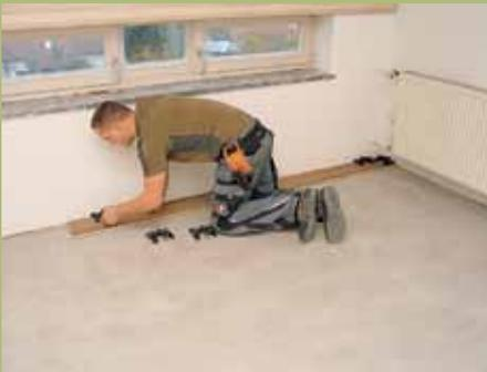
**10. ... und, entkoppelt von der Wand, direkt auf den Untergrund (hier im Kinderzimmer) geklebt. Um eine gleichmäßige geschlossene ...**
