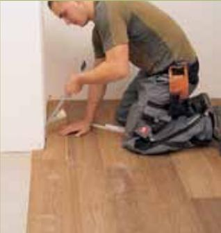
**13.** An der Wand liegende Dielen werden per Zugeisen spaltfrei an die vorige Reihe angeschlossen.
