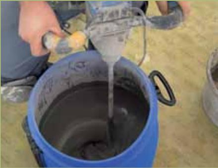
**4. ... in entsprechend großen Mischgefäßen in selbstnivellierender Konsistenz mit dem Rührgerät angerührt werden.**
