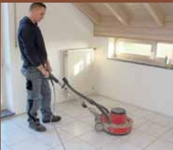
Auch die Fliesen werden zur besseren Haftung des späteren Spachtelauftrags zunächst angeschliffen.
