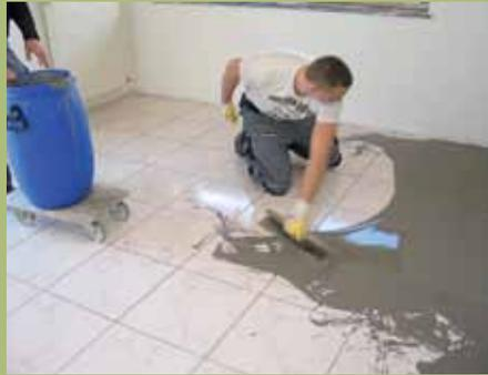
**5. Zur Herstellung eines absolut gleichmäßigen Niveaus der gesamten Verlegefläche wird der Untergrund vollflächig ...**
