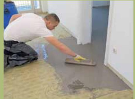
**6. ... mit der zementären, kunstharzvergüteten Glätt- und Nivelliermasse beschichtet und zum Flur hin auf Null abgezogen.**
