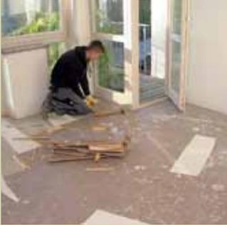
Zunächst wird der alte, aus MDF-Platten bestehende Bodenbelag in Handarbeit entfernt.
