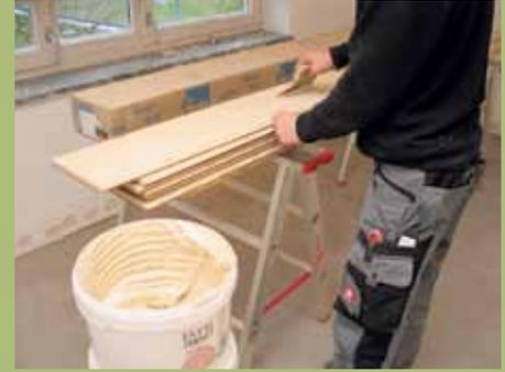
**9.** Danach werden die Eichendielen mittels Zahnpachtel vollflächig mit elastischem, 1-komponentigem Klebstoff beschichtet ...
