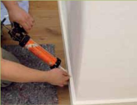
22. Hier wird der Wandspalt mit weißem Silikon (das Bewegungen rissfrei aufnimmt und leicht gereinigt werden kann) geschlossen.
