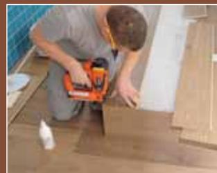
Für einen absolut dauerhaften Verbund werden die Kanten noch mittels Pressluftnagler fixiert.
