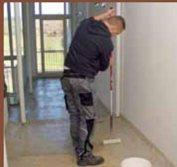
Die Haftgrundierung findet auch im Flur Verwendung, in dem zuvor der alte Teppichboden entfernt wurde.
