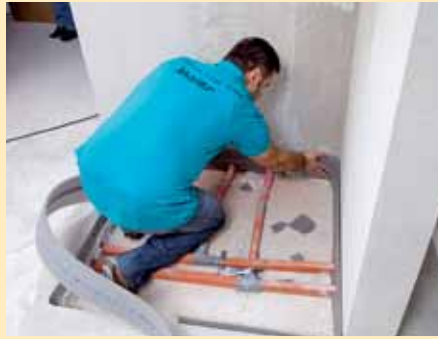
2. Die Duschplatzinstallation beginnt mit dem Anbringen des Randdämmstreifens.
