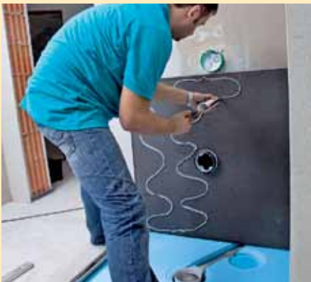
11. Auf die Unterseite des Duschboards wird wiederum der Kleb- und Dichtstoff aus der Kartusche aufgetragen, dann ...
