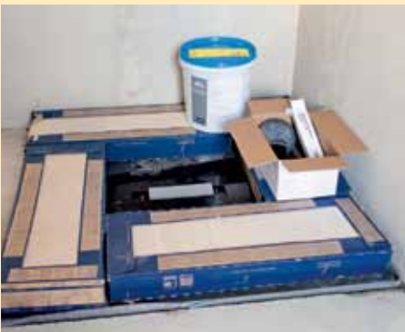
13. Während der Aushärtung des Klebers hat man das Board mit Fliesenpaketen beschwert.
