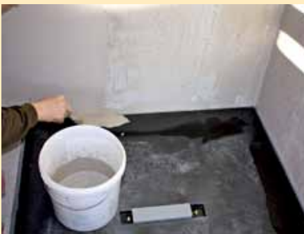
15. Nun bringt der Fliesenleger zunächst in den Randbereichen das Abdichtmaterial auf ...
