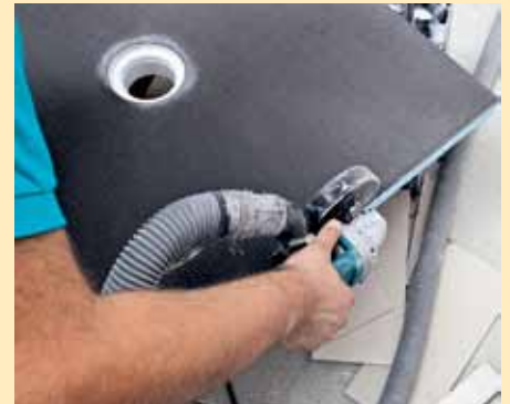
8. Wenn nötig, lassen sich die druckstabilen Duschboards auch vor Ort zuschneiden.
