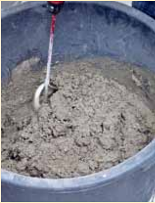
4. ... maschinell mit klarem Wasser im Mörtelkübel angemischt.
