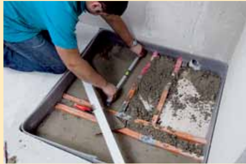
5. Die erdfuchte Ausgleichsmasse muss gut verdichtet und waagrecht eingeschichtet werden.
