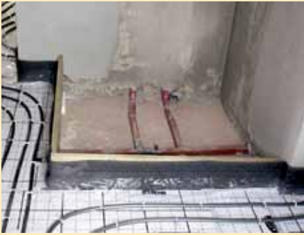
1. Der Duschbereich wurde schon im Rohbaustadium des Hauses ausgespart.
