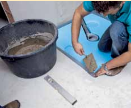
9. Sollte die Aussparung zu groß sein, kann mit Ausgleichsmasse noch nachgebessert werden.
