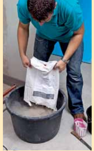
3. Zum Höhenausgleich bis zur Estrichoberkante wurde hier eine spezielle Ausgleichsmasse ...
