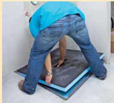
11. Auf die Unterseite des Duschboards wird wiederum der Kleb- und Dichtstoff aus der Kartusche aufgetragen, dann ...
