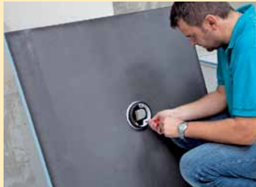
10. Ablauf und Rinne sind werkseitig eingedichtet, der Dichteinsatz unten muss noch angeschraubt werden.
