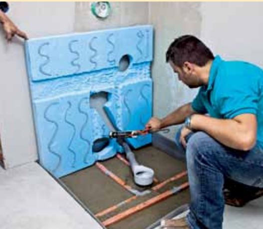
6. An den Unterbauelementen müssen noch individuelle Ausschnitte vorgenommen werden, dann werden sie mit ...
