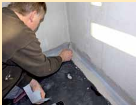
16. ... und arbeitet die Dichtecken und das Dichtband ein, dann wird der Boden behandelt.
