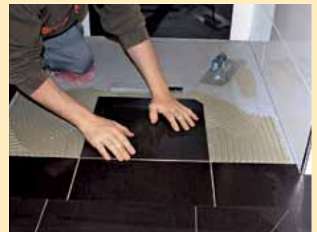
17. Nach Trocknung und dem Fliesen der Wände wird der Boden gefliest. Das ideale Gefälle ...
