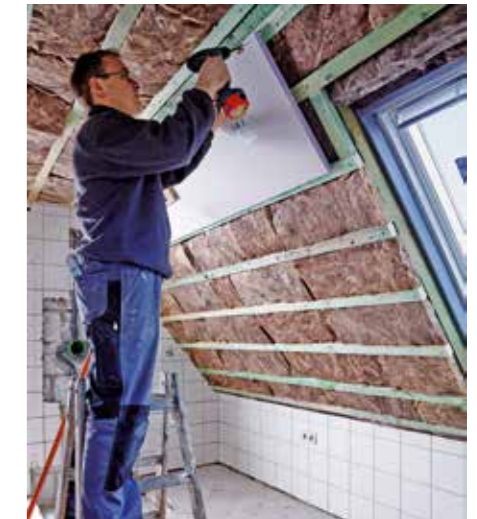
2. Damit es mit der späteren Badfeuchte keine Probleme gibt, hat man die Dachstrahlen mit Hartschaumplatten beplankt.
