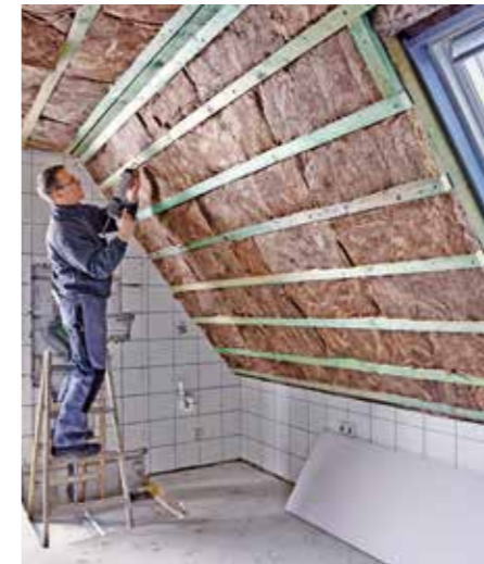
1. Die Badsanierung begann mit dem neuen Dämmbau mit Mineralwolle sowohl zwischen den Sparren als auch raumseitig unterhalb quer.
