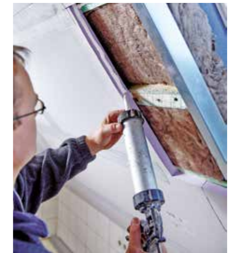
4. Auch die Platten wurden mit Kleber aus der Kartusche dicht miteinander verbunden. So ist die Dämmung vor Raumfeuchte geschützt.
