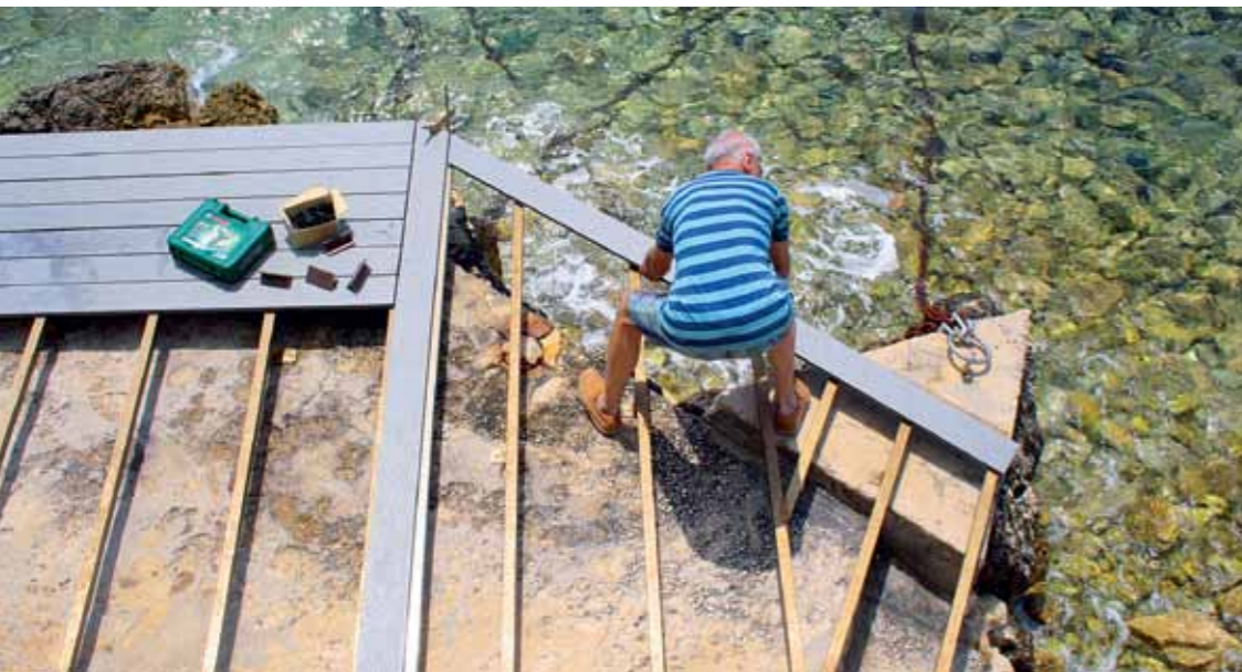
13. Die zweite Teilfläche schließt sich an die abtrennende Längsdiele an – mit entsprechendem Schrägschnitt.
