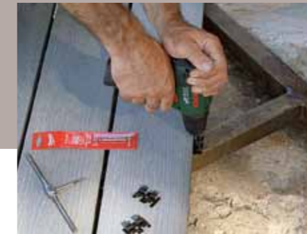
18. Auch die schräge Teilfläche wird mit Doppelklammern und Gewindeschrauben befestigt.
