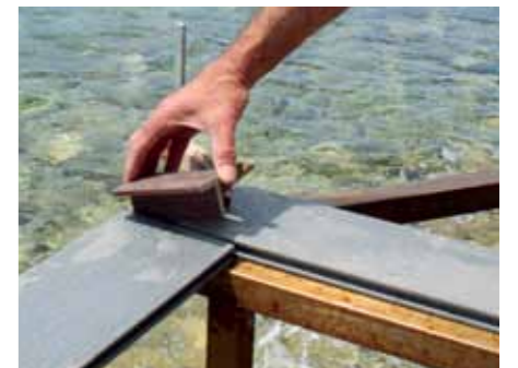
6. Mitgelieferte Abstandshalter sorgen auch am Rahmeneck für einen gleichen Fugenabstand.
