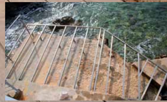
Die Edelstahl-Tragkonstruktion ist sauber ausgerichtet und überdeckt die alte Betonfläche.
