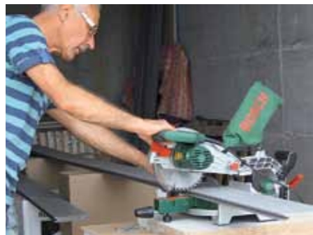
1. Die Dielen der rechteckigen Teilfläche konnten mit der Zugsäge auf Endlänge gebracht werden.
