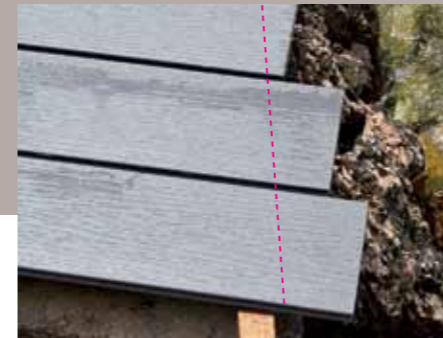
17. Später lässt sich im verlegten Zustand der gerade Abschluss mit der Stichsäge herstellen.
