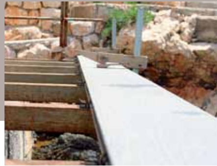
11. Die erste Klammerreihe sitzt (40 Zentimeter Abstand), die erste WPC-Diele ist sicher verlegt.
