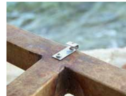
5. Die Außendielen werden durch solche Endklammern gegen Verrutschen gesichert.
