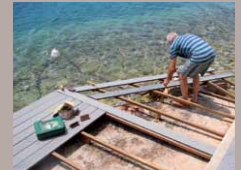
16. ... die Dielen zurecht. Einfacher ist es, sie am offenen Ende mit etwas Überlänge zu verlegen.
