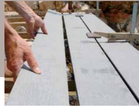
12. Und so schließt sich das Dielendeck nach und nach mit regelmäßigem Fugenbild.
