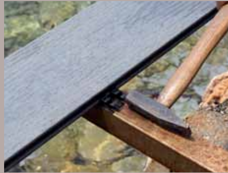
7. Dann können die ersten Doppelklammern mit sanften Schlägen eingeschoben werden.
