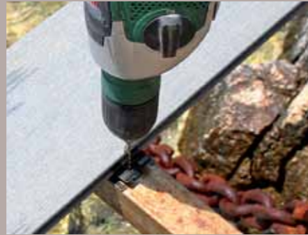
8. Per Edelstahlbohrer durch das Klammerloch bohren und das Loch fürs Gewinde erstellen.
