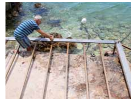
4. Die Randleiele wird festgespannt, rechts die um 90-Grad verdreht verlaufende Trenndiele.
