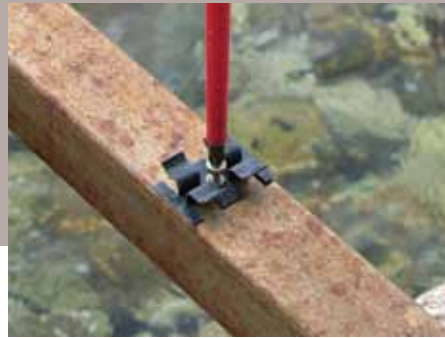
10. So lassen sich dann die Klammern mit einer Edelstahlschraube plus Sprengring festsetzen.
