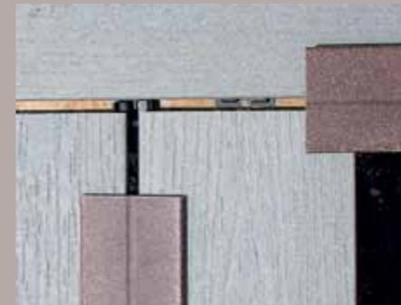
14. Die Fugen am Kopfstoß der Dielen werden ebenso breit wie die Fugen zwischen den Dielen.
