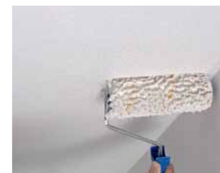
22. Abschließend wird die Decke grundiert und nach Trocknung ein Dekorputz aufgerollt.
