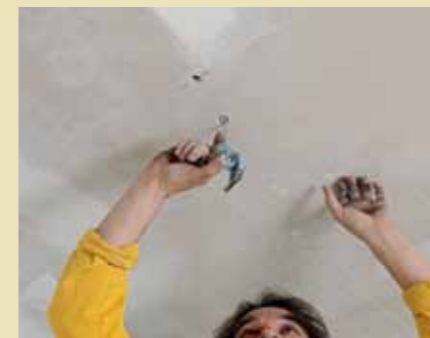
10. ... werden jeweils Ankerfix Schnellabhängiger eingefädelt und fluchtgerecht 27 mm ...
