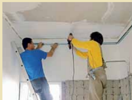
7. Erst werden umlaufend die Wandanschlussprofile angebracht, dann die Deckenprofile ...
