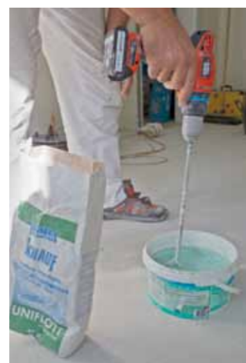
20. Zum Füllen der Plattenfugen wird wasserabweisender Spezialgips angemischt.
