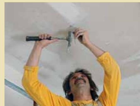
9. Mit speziellen Deckennägeln werden die Abhängedrähte mit Öse befestigt. In diese ...
