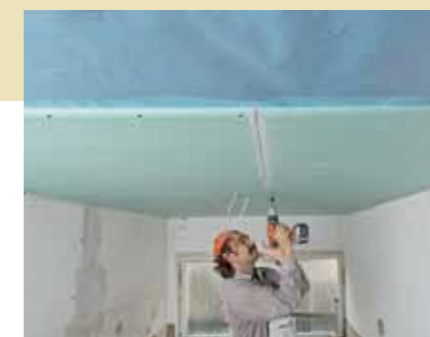
19. Mit Schnellbauschrauben befestigt man die imprägnierten Platten an den Tragprofilen.
