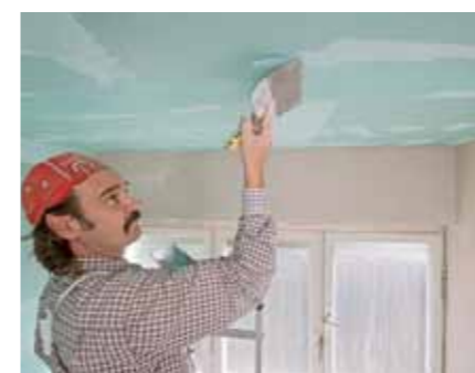
21. Nach dem Verspachteln muss eventuell überstehendes Material abgestoßen werden.
