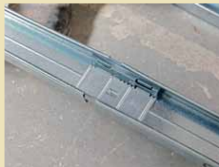
8. ... vorbereitet und bei Bedarf mit Hilfe von Deckenprofilverbindern verlängert.
