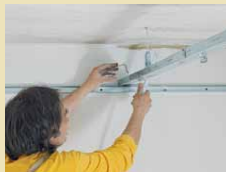
13. Mittels Kreuzverbindern werden nun an die Grundprofile weitere Deckenprofile als ...
