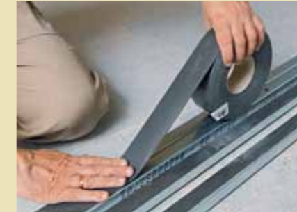
2. Die Wandanschlussprofile werden paarweise mit einem 5 cm breiten Dichtungsband ...
