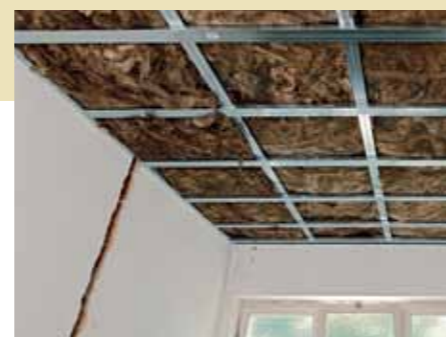
17. ... lückenlos in den Raum oberhalb der Deckenabhängung eingebracht.
