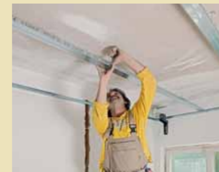
11. ... über dem Wandprofil ausgerichtet. Dann werden die Decken-Grundprofile ...
