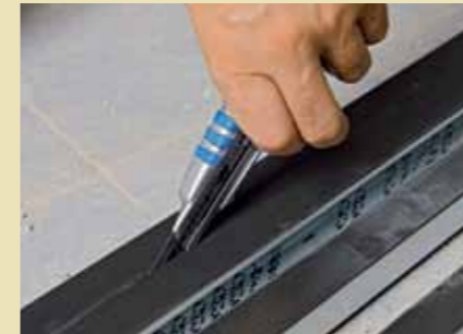
3. ... beklebt und anschließend mit einem scharfen Messer wieder getrennt.
