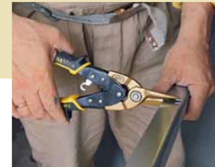
6. Mit einer Blechscheren lassen sich sämtliche Metallprofile passend zuschneiden.
