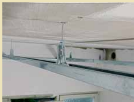
12. ... in die Schnellabhängiger eingedreht und anschließend mit deren Splint arretiert.
