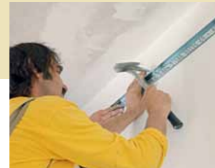
5. ... dann werden die Wandanschlussprofile mit sogenannten Drehstiftdübeln befestigt.
