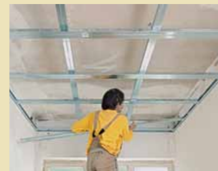
15. ... Tragprofile eingerastet, wandseitig stecken sie in den Wandanschlussprofilen.
