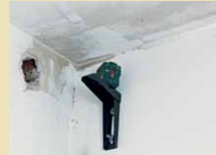
1. Die Einbauhöhe wird mit Hilfe eines Linienlasers umlaufend an den Wänden markiert.
