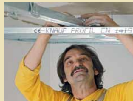
14. ... Tragprofile angedockt. Dazu werden die Verbinder nach unten gebogen, und die ...
