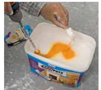
**8.** Erst wird nur eine Portion des Farbtons in den mit 10 % Wasser verdünnten Putz eingestreut.
