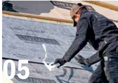
Die reißfeste Polymerbahn an der Oberseite der Elemente steht an der Längs- und Schmalseite um 8 Zentimeter über.
