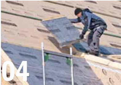
Die Dämmelemente sind leicht zu transportieren und können mühelos von einer Person auf dem Steildach verlegt werden.
