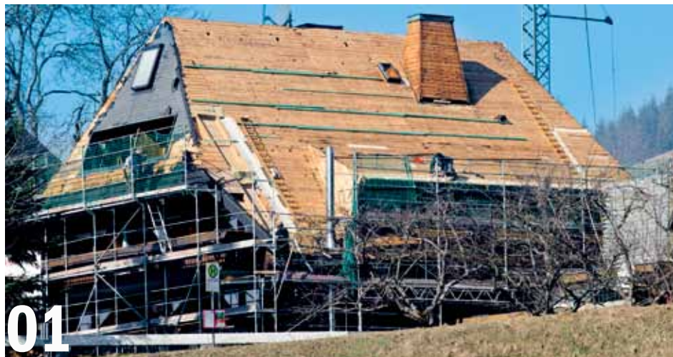
Vorbereitung für die Dacheindeckung: Nach Abdecken der Bitumenschindeln ist das Unterdach aus Holzbrettern sichtbar.
