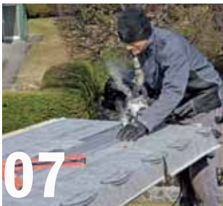
Per Elektrohandkreissäge werden die angezeichneten Platten jeweils passgenau zugeschnitten.
