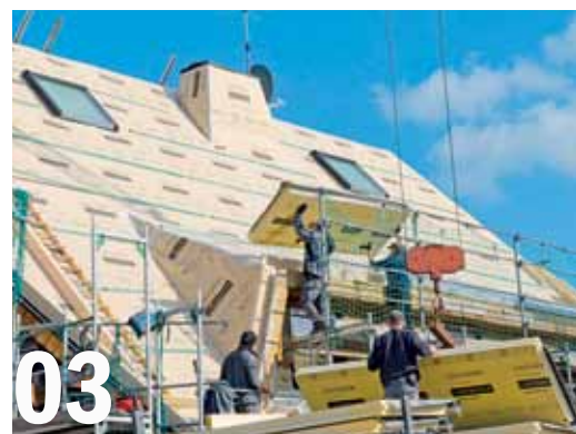
Die Linitherm PAL Polymer-Elemente kommen aufs Dach. Das Verlegen beginnt an den Schubhölzern auf der Traufseite.
