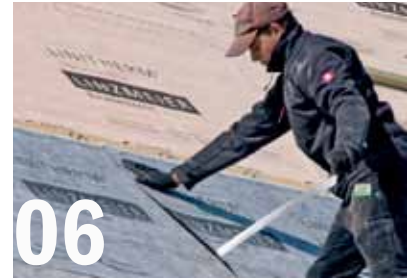
So können die Dachdecker die Dichtbänder an den Überlappungen nach Abziehen der Schutzfolie andrücken und verkleben.
