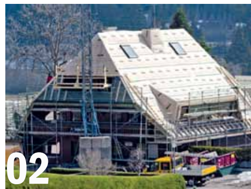
Im zweiten Schritt hat die Firma Braun & Heine die L + D Folie verlegt. Sie fungiert als luftdichte Ebene unter der Dämmung.
