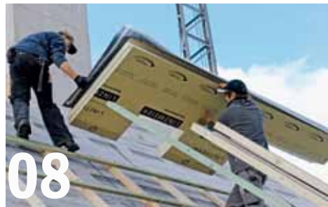
So lassen sich z. B. Ausschnitte für Schornsteine und andere Dachdurchdringungen oder Anschlüsse an Gauben schnell auf der Baustelle umsetzen.
