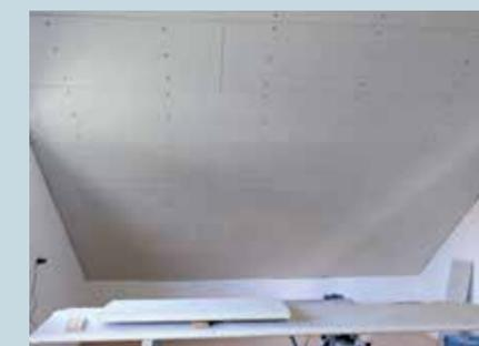
6. So sieht dann eine von innen gedämmte und gleichzeitig verkleidete Schräge aus.
