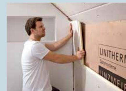
7. Am Kniestock die entsprechende Platte passgenau ansträgen und lückenlos anschließen.
