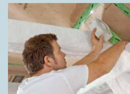
3. Wo es komplizierter wird, hilft entsprechendes Abkleben mit dem Dichtband.
