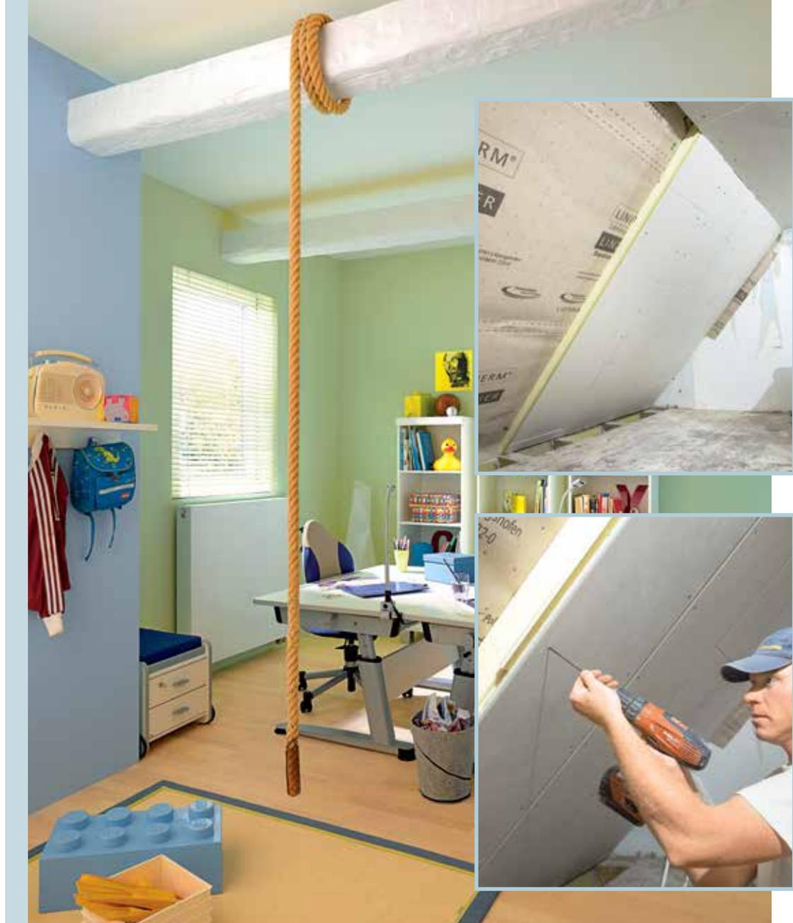
**Großflächige Dachschrägen oder auch durchlaufende senkrechte Wände lassen sich auch mit hochkant verlegten Platten bekleiden.**
