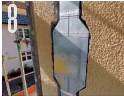
**8** Putz und Mauerwerk der Altfassade wurden in Teilbereichen eingeschlitzt, um die Lüftungskanäle einbringen zu können.
