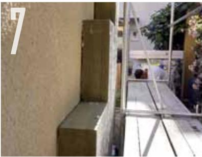
**7** Die ganze Fassade wurde von unten nach oben vollflächig mit 20 Zentimeter dicken Mineralwolleplatten eingepackt.
