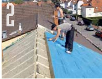
**2** Zwischen die aufgedoppelten Sparren kam Mineralwollefilz, oben drauf wurden vollflächig Mineralwolleplatten aufgelegt.
