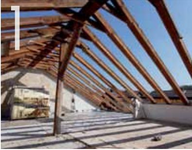
**1** Hier sollte hochwertiger Dachraum entstehen. Doch zuvor musste der filigrane Dachstuhl zum Dämmen verstärkt werden.
