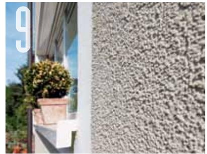
**9** Der neue Oberputz ist Teil des Wärmedämm-Systems – ein hochdiffusionsfähiges Produkt mit dekorativer Struktur.
