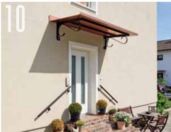
**Statt ungenutztem kleinem Balkon mit thermisch problematischer Betonplatte (weil Wärmebrücke) ziert nun ein Vordach den Eingangsbereich – thermisch entkoppelt und trotz Dämmhülle sicher verankert im Mauerwerk.**
