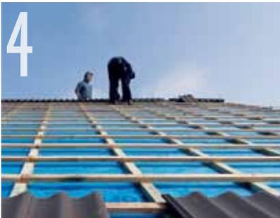
**4** Wetterfeste Außenhaut über der Dämmebene: Auf Konterlattung und Lattung verlegten die Profis Betondachsteine ...
