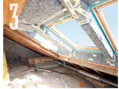
**3** Von innen wurden der gesamte Dachschrägenbereich samt neuen Dachfenstern mit einer Dampfbremshahn abgedichtet.
