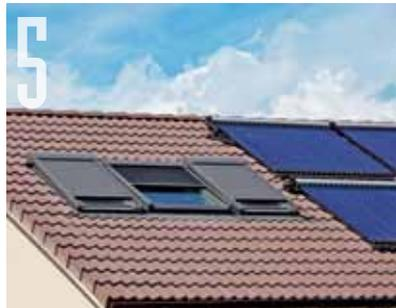
**5** ... mit reinigungsoptimierter Oberfläche. Zudem kamen vier Röhrenkollektoren für Heizung und Warmwasser aufs Dach.
