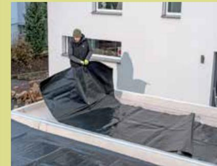
1. Zuerst das abgedichtete Dach mit der Wurzelschutzfolie abdecken. Überlappung ca. 50 cm.
