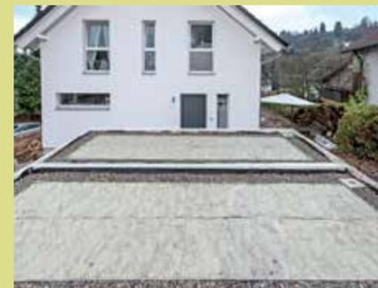
17. Damit ist die Verwurzelungs- sowie Wasserspeicherlage bereit für die Vegetationsmatten.
