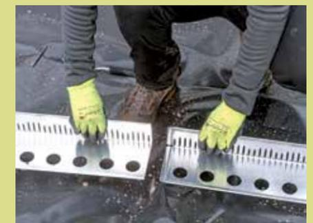
6. Die 2,5 m langen Profile können der Länge nach zusammengesteckt werden. Am Ende ...
