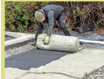
16. Die Bahnen einfach dicht gestoßen verlegen und gegebenenfalls an den Enden abschneiden.
