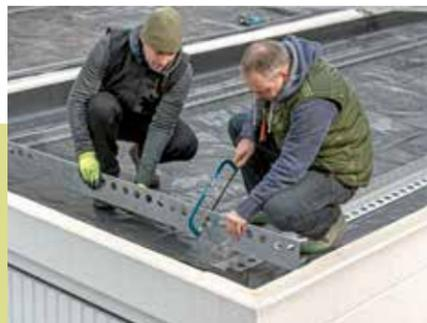
7. ... lassen sich die Profile leicht mit einer Eisen-säge ablängen. Damit dann ein stabiler ...
