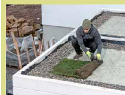
18. Diese werden dicht am Aluprofil angesetzt und entlang ausgerollt. Die Matten sind gut ...
