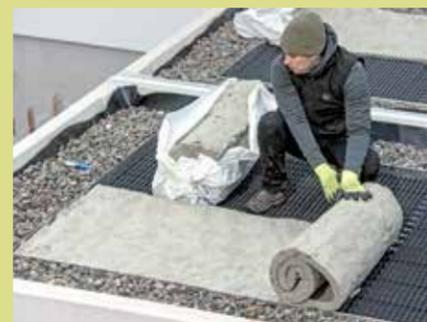
15. Anschließend rollt man auch sofort die Substratmatten aus Spezial-Steinwolle aus.
