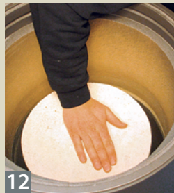
07 ... um dann darauf das aus schwerem, massivem Ofenschamott bestehende Deckenrondell aufsetzen zu können.
