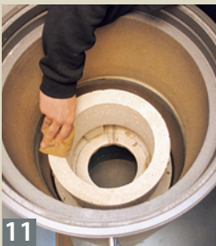
06 Für eine dichte Auflage der Feuerraumdecke wird nach dem Setzen des dritten Rings Schamottemörtel aufgetragen, ...
