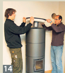
09 Jetzt wird der ebenfalls mit massivem Ofenschamott bestückte obere Ring aufgesetzt und wie die anderen ausgerichtet.
