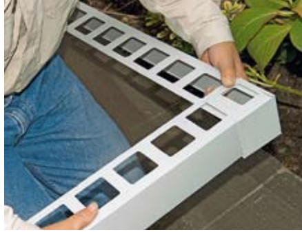
2. Die Winkelrandprofile werden passend zugeschnitten. An den Ecken kommen Eckstücke, an den Stößen Profilverbinder zum Einsatz.
