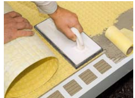
6. ... von der Wand weg weiter und führt die Matte bis dicht an den Auflageschenkel des Randprofils heran. Über das Randprofil ...
