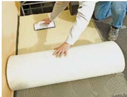
5. Nun wird die Entkopplungsmatte (Durabase CI) mit der Vliesseite nach unten ins Mörtelbett eingelegt und angedrückt. Man arbeitet ...
