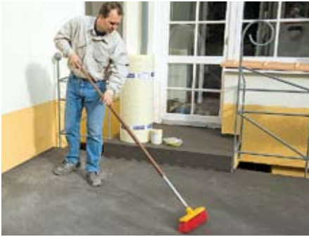
1. Der von den alten Fliesen befreite Gefälleestrich wird nach Bedarf gespachtelt, grundiert und vor den weiteren Arbeiten gereinigt.
