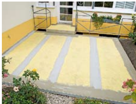
8. Sind auch alle Bahnenstöße mit Dichtband und Flexmörtel überarbeitet, hat man eine fertig entkoppelte Balkon- bzw. Terrassenfläche.
