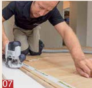
**07** Denn nun wird hier wegen des Treppenlängsbretts noch eine Seitennut in diese Kantenstrecke gefräst. Der Nutfräser-Vorsatz ...
