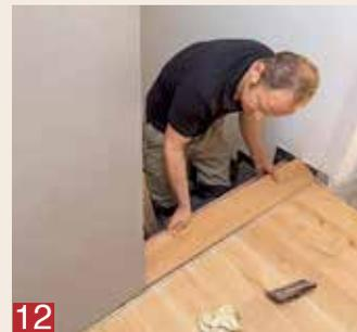
**12** Zum Schluss fügt man das Treppenbrett hinzu, das per Nut-Feder-Verbindung (vgl. Abb. 8) versatzfrei den Übergang schafft.
