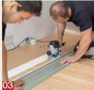
**03** Wenn die Markierungslinie exakt als Linie durchläuft, wird mit der Oberfräse die Nut in entsprechender Länge und Tiefe erstellt.
