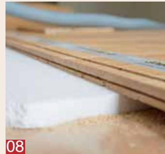
**08** ... wird so auf Höhe und Tiefe eingestellt, dass die Feder des später anzusetzenden Dielenstücks perfekt in diese erstellte Nut passt.
