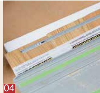
**04** Probalter setzt man die Bodenlaufschiene einmal ein und prüft auf bündigen und passgenauen Sitz. Gegebenenfalls ...
