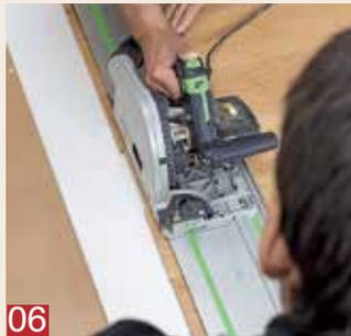
**06** Immer noch unverrückt liegend lassen sich jetzt auch die Querkanten auf Linie bringen – mit schienengeführter Handkreissäge.
