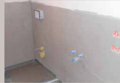
8. Die ziemlich ramponierte Wand wird verfüllt und mit Rohbauspachtel egalisiert.
