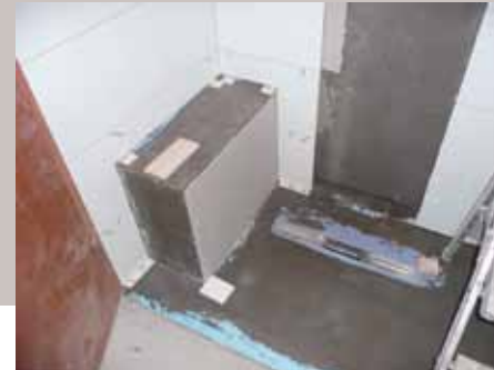
11. Die Duschbank wird aufgemauert und der gesamte Spritzwasserbereich abgedichtet.
