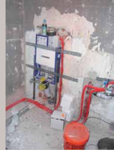
4. ... Unterputzspülkasten noch etwas vergrößert werden.
