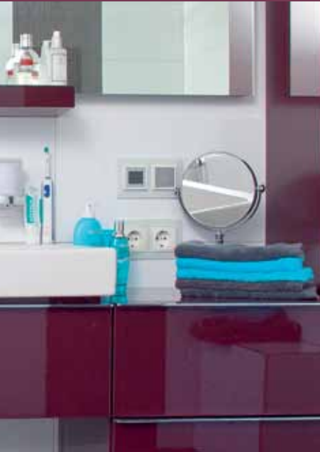
Über den Steckdosen ist ein Miniradio in zwei Unterputzdosen eingebaut.
