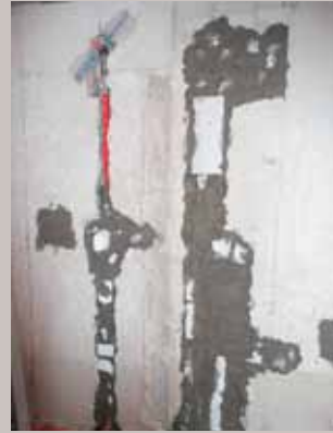
6. Die Leitungen für die Duscharmatur sind jetzt an der anderen Wand der Ecke.
