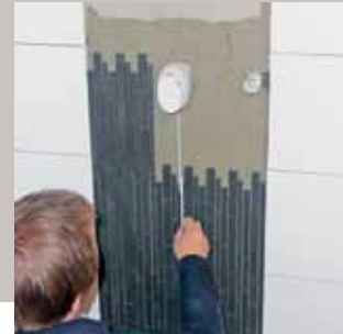
13. Die Duschwand wird mit einem „Wasserfall“ aus anthrazitfarbenen Kleinfliesen gestaltet.
