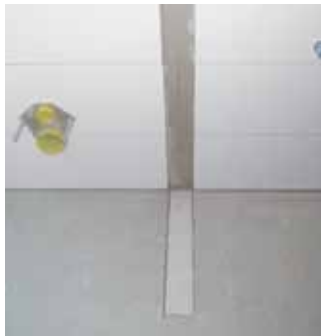
14. Die Bereiche für die kleinen Trennwände bleiben an Wand und Boden ausgespart.
