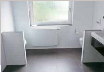
22. Der weiße Planheizkörper wird unter dem jetzt weiß lackierten Fenster angeschlossen.
