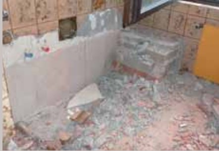
1. Die Sanitärobjekte werden entfernt, die Duschwand und der Wannenunterbau abgeschlagen.
