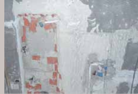
3. Die schon vorhandene Vertiefung in der Wand musste für das neue Montageelement mit ...
