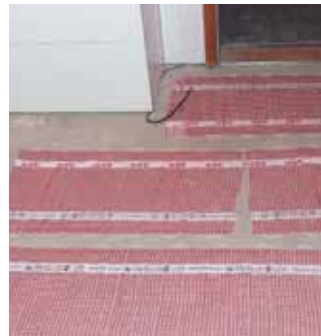
15. Die Heizmatten der Elektrofußbodenheizung werden auf dem Boden ausgelegt.
