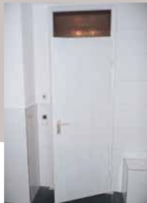
23. Die braune Holzür wird weiß grundiert und dann endlackiert.
