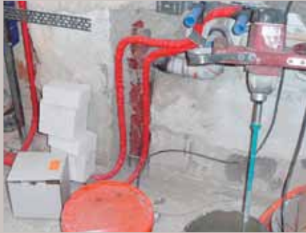
5. Sämtliche durch das Badezimmer führenden Leitungen werden erneuert.
