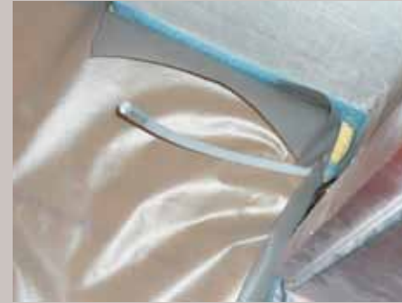
7. Auf dem Rohboden wird eine Folie ausgelegt, zu den Wänden hin Dämmstreifen eingebaut.
