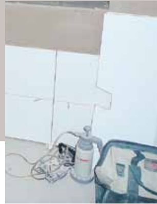
10. Die ersten der 30 mal 60 cm großen Fliesen werden an die Wand geklebt.
