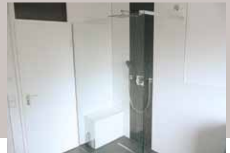
24. Schließlich wird die Festscheibe für die Duschtrennung angeliefert und montiert.
