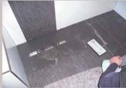
18. Kleinformatige Fliesen sind ideal zum Auslegen des Gefällebodens der Dusche. Sie ...
