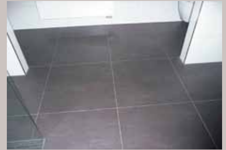
19. ... werden mit dem gleichen Mörtel ausgefugt wie die 60 mal 60 cm großen Bodenfliesen.
