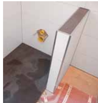
16. Die Trennwände werden aufgemauert und verfliesen. Sie teilen den Raum und dienen auch als Stützen.
