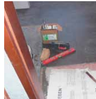
17. Die Dünnbettheizmatten werden beim Verliesen des Bodens in die Kleberschicht eingearbeitet.
