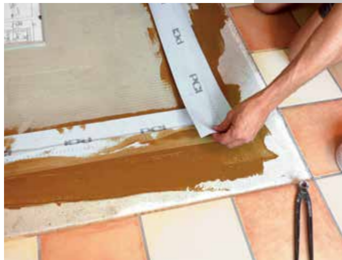
8. Mit speziellen Dichtbändern wird nun auch der Bereich rund um den Anschluss von Schaumplatten und bestehendem Estrich gelegt und mit Fliesenkleber wasserdicht verklebt.
