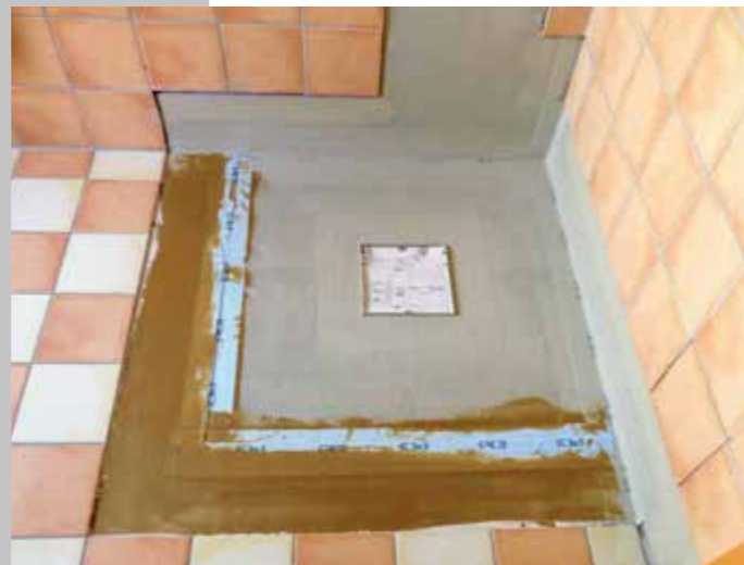
9. Die so vorbereitete Fläche kann nun mit Fliesen beklebt werden. Diese folgen dann der Gefälleaufteilung des Unterbaus, wurden also in diesem Fall ebenfalls auf Gehrung geschnitten. (vgl. Abbildung S. 30)
