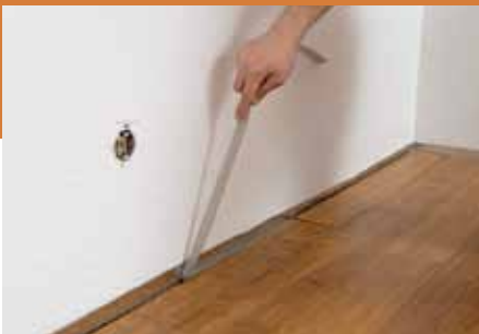
15. Trick am Schluss: Das Distanz-Schaumstoffband kann nun ganz herausgezogen werden.
