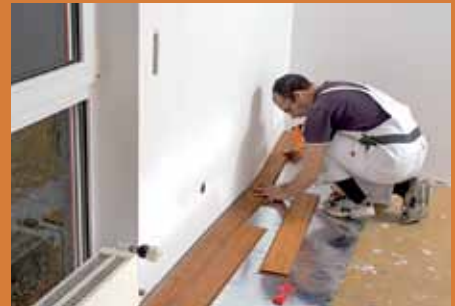
6. ... den wilden Verband gewählt, bei dem Reihe für Reihe durchverlegt werden.
