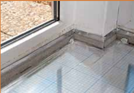
4. An den anderen Wänden verklebt man die Klebestreifen mit integriertem Distanzschaum.
