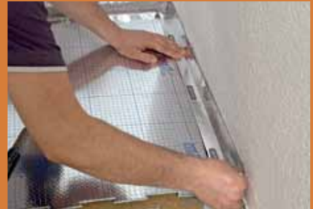
3. Mit dem Alu-Knickstreifen wird an zwei sich berührenden Wandseiten sauber abgeklebt.
