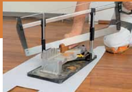
16. Und wenn dann die dekorgleichen Sockelleisten – diese am besten auf Gehrung sägen, ...
