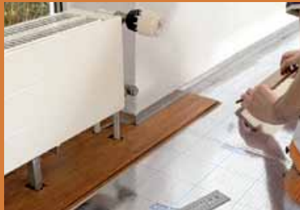
5. Unser Bambusboden ist als Klickboden so zu verlegen wie Fertigparkett auch. Hier hat man ...
