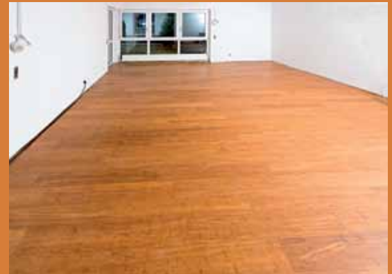
14. Fertig verlegter Boden. Der wilde Verband ist hier kaum zu sehen, da die Fläche insgesamt wahrgenommen wird.
