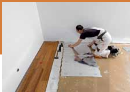
8. Nach vier Dielenreihen schließt man die nächsten Folienplatten per Verzahnung an.
