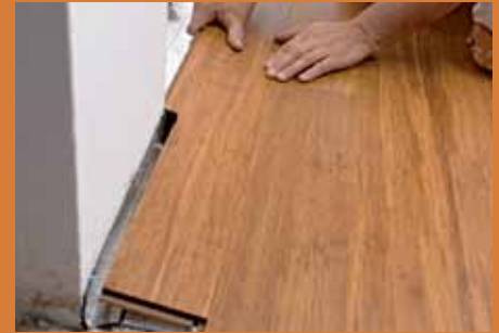
11. Beim Verkllicken verschwinden die Fugen zwischen den Dielenelementen nahezu.
