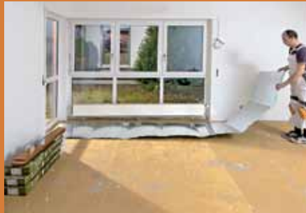
2. ... und wird einfach aufgefaltet. Die Alu-Folieerung dient als Feuchtigkeitssperre (über Keller).
