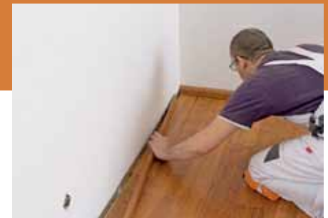
17. ... verlegt werden, hat man einen Boden aus einem Guss. Die Fuge wird sicher abgedeckt.
