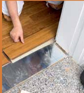
13. Bei Türübergängen wird auch die Trittschallunterlage bis an den vorhandenen Belag heran verlegt.
