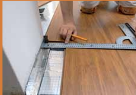
10. Das Einpassen der letzten Dielenreihe geschieht durch maßgenauen Zuschnitt.
