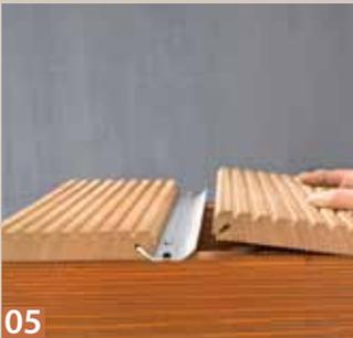
**05** Falls die Dielen etwas unförmig sind, muss man die Befestigungsschrauben leicht lösen und den Belag richtig positionieren.
