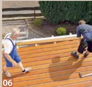
**06** Nach und nach entsteht so ein schmutz- und weitgehend wasserundurchlässiger Bodenbelag auf der Unterkonstruktion.
