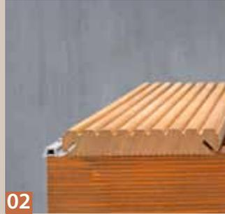
**02** Mit einem zugeschnittenen halben Anfangs-Wing wird die erste Diele auf der einen Seite auf der Unterkonstruktion fixiert.
