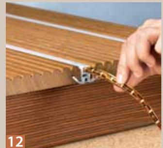
**12** Andere Variante: Das LED-Band durch die Hohlkammer des Abdeckprofils führen und an den Markierungen kürzen.
