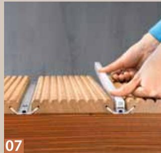
**07** Zum Schluss werden die Abdeckprofile aufgeklippt. Sie bilden mit dem Belag eine ebene Fläche und schützen die Schrauben.
