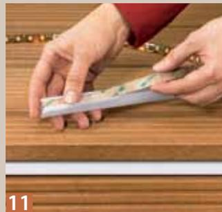
**11** ... oder umgedreht in das Abdeckprofil – im Beleuchtungsfall dann selbstverständlich ein weißes Profil – einlegen.
