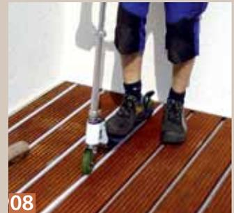
**08** Kleiner Trick bei großen Flächen: Die Abdeckprofile mit Hilfe eines gummiereiften Cityrollers in die Halteprofile drücken.
