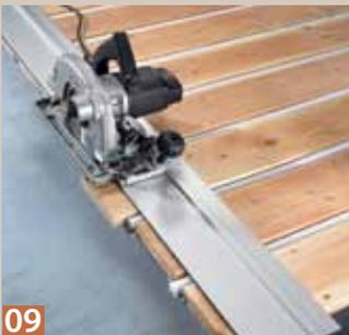
**09** Am Ende der Bodenverlegung kann mit einer Kreissäge an der Führungsschiene ein sauberer Abschluss erzielt werden.
