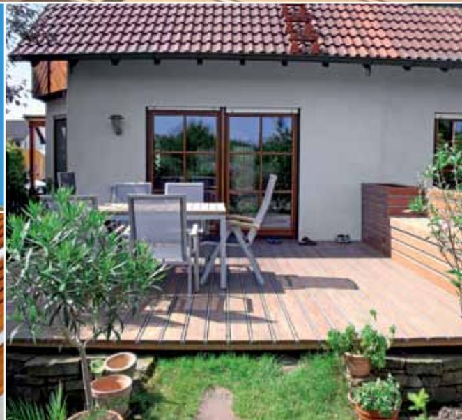
**M**it dem Verlegesystem Alpha-Wing lassen sich schmutzdichte und weitgehend wasserdichte Flächen mit Holz und WPC (Wood Polymer Composite) bauen. Die darunterliegenden Bereiche bleiben sauber und trocken. Voraussetzung: Alpha-Wing muss mit hochwertigem Holz oder geeignetem WPC kombiniert werden. Absolute
