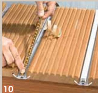
**10** Als dekoratives Element oder zu Sicherheitszwecken kann man LED-Lichtbänder integrieren. Entweder aufs Halteprofil kleben, ...
