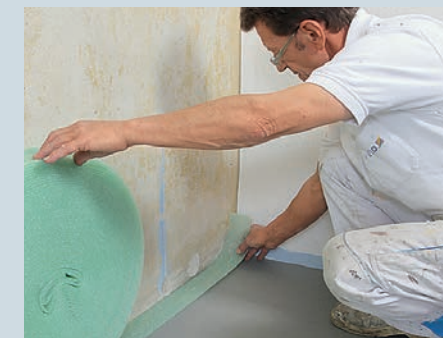
3. Bevor die Dämmplatten an die Wand gebracht werden, legt man zunächst das Schaumstoff-Entkopplungsband am Boden aus.
