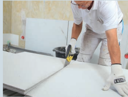
7. Der Zuschnitt der Glasschaumgranulatplatte lässt sich manuell mit einem Fuchsschwanz ausführen oder auch mit einer Elektro-Stichsäge.
