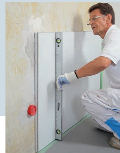
5. Hierbei gilt es auch, die Platte lotrecht auszurichten. Das Kleberbett bietet dafür genügend Volumen, um nachzujustieren.
