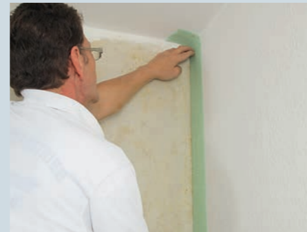
10. Nicht vergessen sollte man, auch im Wandwinkel und an der Decke den Schaumstreifen lückenlos einzulegen bzw. anzukleben.
