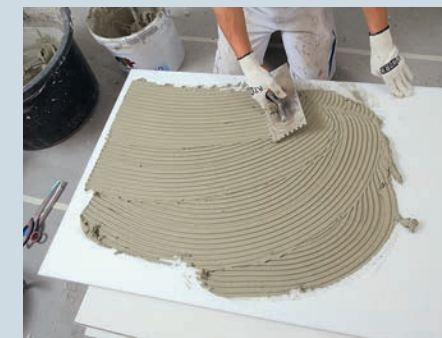
2. Der Kleberauftrag erfolgt auf der Rückseite der Dämmplatten und zwar vollflächig und mit einer Zahntraufel mit 8 mm Kammbethöhe.
