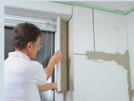
12. Hier erkennt man, wie der Profi auch das Fenster in die Dämmebene eingebunden hat. Hier eventuell die dünnere Platte verlegen.
