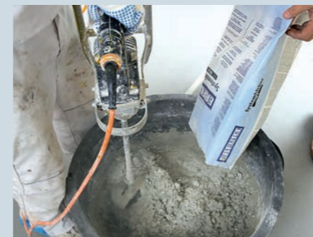
1. Das Ansetzen des pulverförmigen mineralischen Systemklebers erfolgt nach Maßgabe des Herstellers mit geeigneter Rührmaschine.
