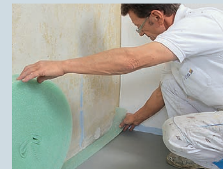
3. Bevor die Dämmplatten an die Wand gebracht werden, legt man zunächst das Schaumstoff-Entkopplungsband am Boden aus.
