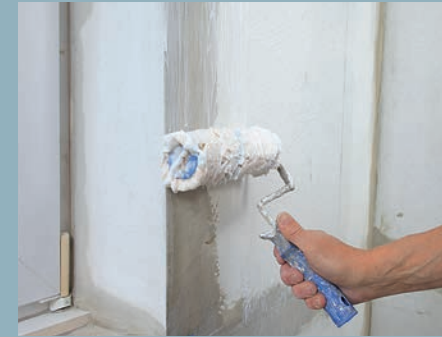
16. Hier kam nun eine Vlies-Rauhfaser in Wandklebertechnik zum Einsatz. Der zuvor angesetzte Kleister wird mit einer Fellrolle aufgewalzt.
