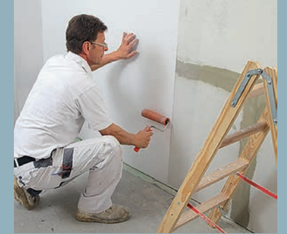
18. Zum Schluss wird mit einer Andrückrolle alles flächig überarbeitet. Die neue Wand wartet nun auf die Farbgestaltung.
