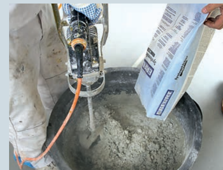
1. Das Ansetzen des pulverförmigen mineralischen Systemklebers erfolgt nach Maßgabe des Herstellers mit geeigneter Rührmaschine.
