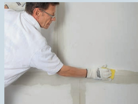
15. Gut ausgetrocknet werden die Spachtelflächen bündig abgeschliffen (evtl. etwas nachspachteln). Damit ist alles tapezierfertig.
