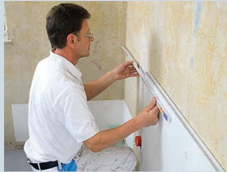
6. Am Ende der ersten Reihe ergibt sich eine Restfläche, die genau abgemessen und mit einer zugeschnittenen Platte gefüllt wird.
