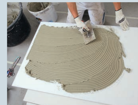
2. Der Kleberauftrag erfolgt auf der Rückseite der Dämmplatten und zwar vollflächig und mit einer Zahntraufel mit 8 mm Kammbethöhe.
