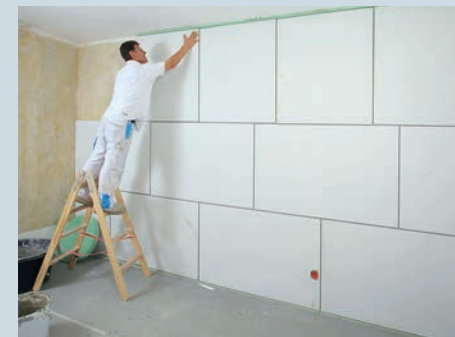
11. Da die Plattenhöhe 800 mm misst, ist man mit Reihe drei schon an der Decke. Hier passt man dann die Platten ein. (vgl. Kasten rechts)
