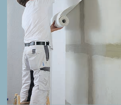
17. Die Bahnen werden an der Decke ausgerichtet, senkrecht nach unten ausgerollt und ins Kleisterbett gedrückt.
