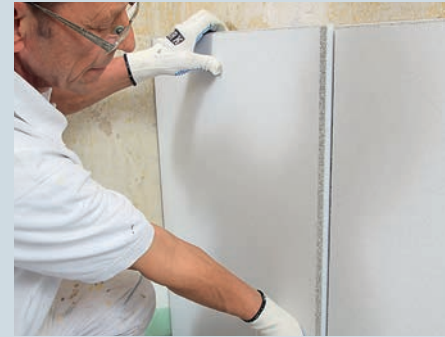
8. Der leichte Stufenfalz sorgt für eine versatzfreie und dichte Dämmebene. Hinten sieht man das Spezialvlies als zweite Plattenkomponente.
