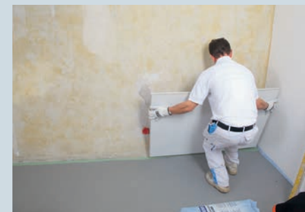
4. Die erste Dämmplatte wird nun aufgestellt und dann schwimmend (mit leichter Hin- und Herbewegung) an die Wand gedrückt.
