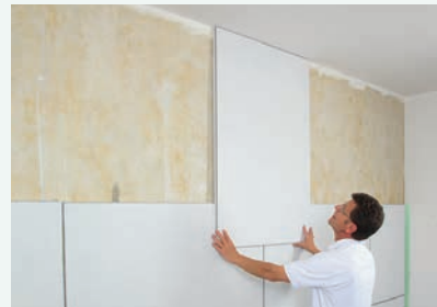
10. Nicht vergessen sollte man, auch im Wandwinkel und an der Decke den Schaumstreifen lückenlos einzulegen bzw. anzukleben.
