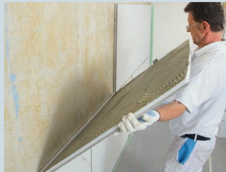
9. Die zweite Reihe beginnt mit dem Reststück von Reihe eins und setzt sich dann im versetzten Verband (mindestens 250 mm) fort.
