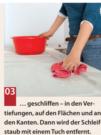
02 Nun wird der Untergrund vorbereitet. Erst wird er mit einem Ablauger und Entfetter gereinigt, dann mit 240er Schleifpapier ...
