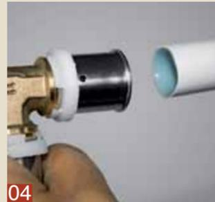
**04** Nun das Rohr unter Druck und drehend in die Hülse und bis zum Anschlag des Fittings schieben. Durch das Sichtloch ...
