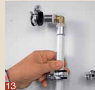
**13** Die ersten Rohrabschnitte werden mit den Schellen fixiert. Die Fittinghülsen sind hierbei aber noch nicht verpresst.
