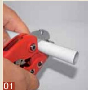
**01** Das Rohr wird mittels der Rohrschneidezange auf das erforderliche Maß abgelängt. Rohr rechtwinklig abschneiden!
