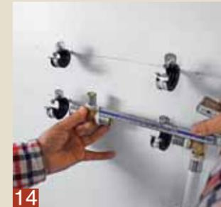
**14** Ein T-Fitting wird zum Beispiel an seiner späteren Position gehalten und dann das entsprechende Rohrlängenmaß ermittelt.
