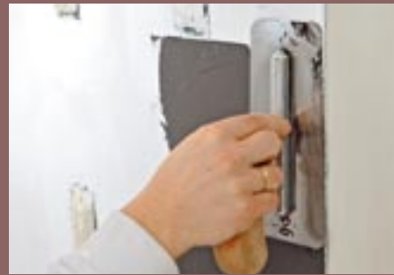
11. An Außenkanten die Spachtel genau ansetzen und das Material nach innen ziehen.
