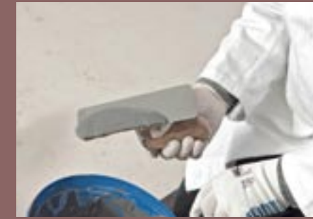
17. Diesmal hat man die Kalkspachtel etwas heller eingefärbt, um weitere Effekte zu erzielen.
