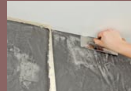
21. Wenn das Abklebeband entfernt worden ist, eventuell im Winkel noch einmal nacharbeiten.
