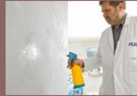
16. Für die zweite Schicht empfiehlt es sich, die gesamte Wandfläche erst leicht vorzunässen.
