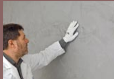
15. Der erste Auftrag ist trocken (und heller geworden). Grobe Grate abtasten und beischleifen.
