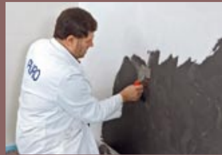
12. Mit leichtem Anpressdruck arbeiten und die Kelle dabei eher flacher als zu steil anwinkeln.
