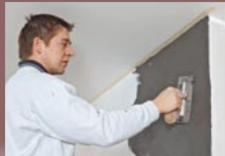
14. Zur Decke hin ist es ratsam, ein Klebeband zu verlegen: So hat man später eine klare Trennung.
