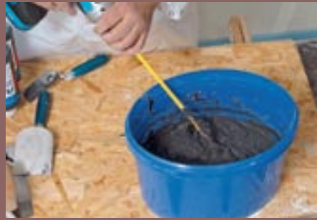
9. Wenn keine weißen Reste mehr erkennbar sind, ist das Produkt verarbeitungsfertig.
