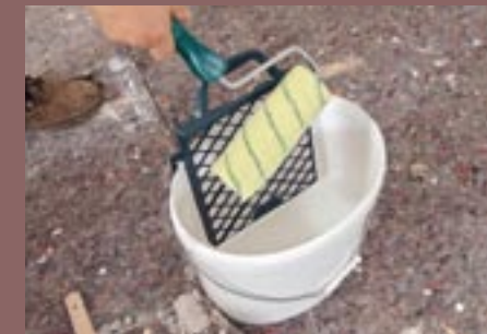
3. Das richtige Werkzeug für den nachfolgenden Flächenauftrag ist die mittelflorige Fellwalze.
