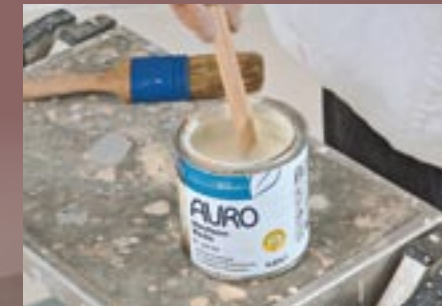
23. Etwas mehr Glanzeffekte und vor allem Schutz vor Feuchtigkeit erreicht man, wenn noch eine Speziallasur aufgetragen wird.
