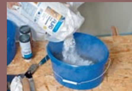
7. Jetzt erst werden die drei Kilo Kalkspachtel-Pulver eingestreut. Ist dann die Konsistenz ...
