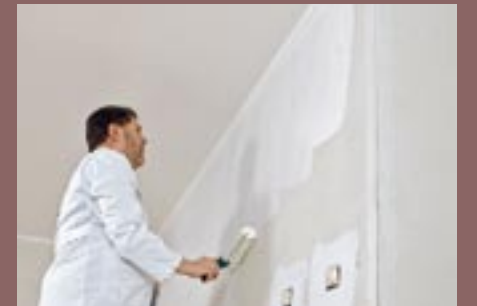
4. Wie eine Wandfarbe wird die Grundierung aufgerollt. Sie trocknet auch schnell auf.
