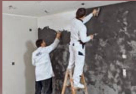
13. Für den Erstauftrag ist ein Helfer praktisch, die zweite Schicht sollte eine Person ausführen.
