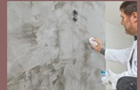
24. Die transparente Flüssigkeit wird mit Tuchballen und bei leichtem Druck eingerieben.
