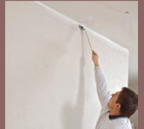
2. Zuerst alle Wandwinkel mit einem Flachpinsel oder Heizkörperpinsel vorstreichen.
