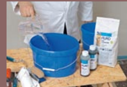
5. Zum Anmischen des Kalkspachtels wird ein sauberer Eimer gebraucht und reines Wasser.
