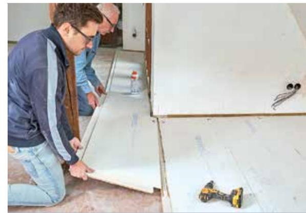
**17** Jetzt sind wir wieder nahe der Anfangssituation. Rechts der fertige Bereich des Raum-„L"s, links von hinten kommend die ersten Platten. Die Reihe schließt jetzt exakt fugentreu an.
