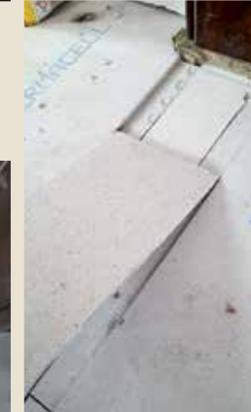
**E** Wenn die untere Lücke zum Rohboden mit einem losen Plattenstreifen inklusive Holzfaserunterlage gefüllt ist, legt man das Passstück ein.
