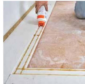
**11** Und so sieht die Verklebung aus: Auf der schmalen ersten Reihe sorgt die Doppelspur für die nächste Reihe aus ganzen ...
