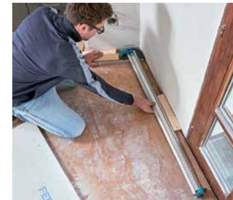
**4** Eine erste Hürde: Das exakte Ermitteln des Winkels an der schräg weglaufenden Raumwand. Mit Hilfe einer Winkelschiene kann man die Situation gradgenau ...
