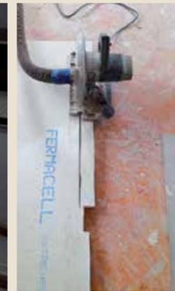
**C** Die Kreissäge dazu auf 1 cm Schnitttiefe einstellen und die Gipsfaserplatte exakt um diese Tiefe einschneiden. Dann lässt sich die ...
