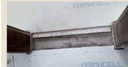
**B** Dann wird für den verbleibenden Schwellenbereich ein Passstück gefertigt. Dazu zuvor einen 5 cm breiten Streifen von der jeweiligen oberen Plattenlage abnehmen. Damit wird ein beidseitiger Stufenfalz hergestellt, der dann die Verklebung des Passstücks im Verbund mit den ganzen Platten ermöglicht.
