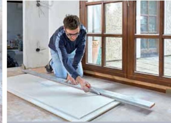
**2** Damit die Randplatten dicht und kompakt vor der Wand enden können, werden die überstehenden fünf Zentimeter der obersten Platte (Stufenfalz) abgetrennt. Eine gezogene Linie hilft beim nachfolgenden Sägen.
