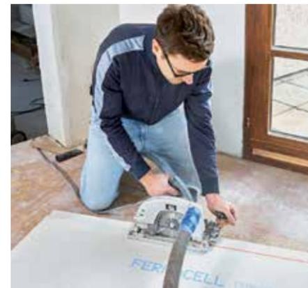
**3** Mit der Handkreissäge und auf 10 Millimeter Schnitttiefe eingestellt lassen sich die Plattenüberstände sauber und linientreu absägen.
