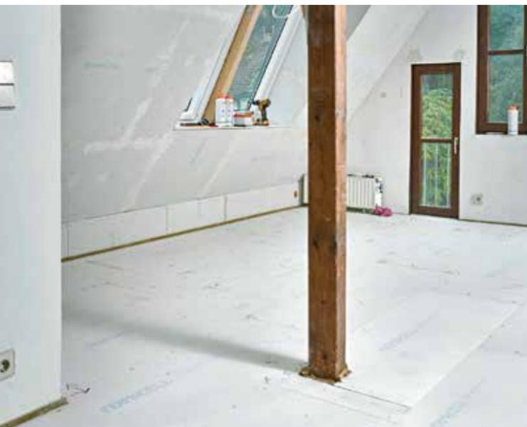
**23** Blick in Richtung Giebelseite. Der drei Zentimeter hohe Neuaufbau aus Gipsfaser-Estrichelementen lässt noch Freiraum für die bodentiefen Fenster, auch wenn dann noch der Gehbelag aufgebracht wird.
