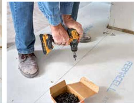
**18** Das Verschrauben erfolgt mit kurzen Schrauben im Abstand von etwa 20 cm. Um den Anfangspressdruck sicherzustellen, das eigenen Körpergewicht einsetzen.
