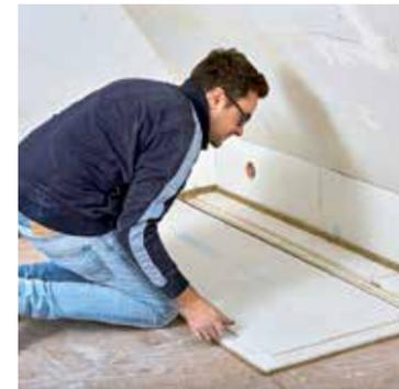
**12** ... Platten für eine sichere Stufenfalz-Verbindung. Platte heranschieben und dann leicht anheben.
