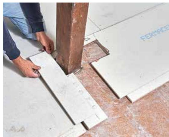
**20** Mit Hilfe eines Zwischenstücks, das rechts einen selbst angefertigten Stufenfalz bekam, um die nächste Platte anschließen zu können, wurde der Pfosten umlegt.
