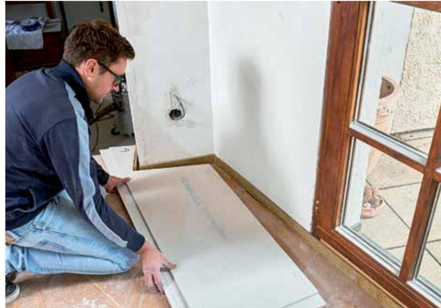
**7** Jetzt beginnt die Verlegung des neuen Bodens. Beim Zuschnitt muss dann eben auch der Randdämmstreifen berücksichtigt werden. Hinten an der Platte erkennt man den passgenauen Zuschnitt des Elements, um in die Laibung und bis an die Vorderkante der Stufe zu kommen.
