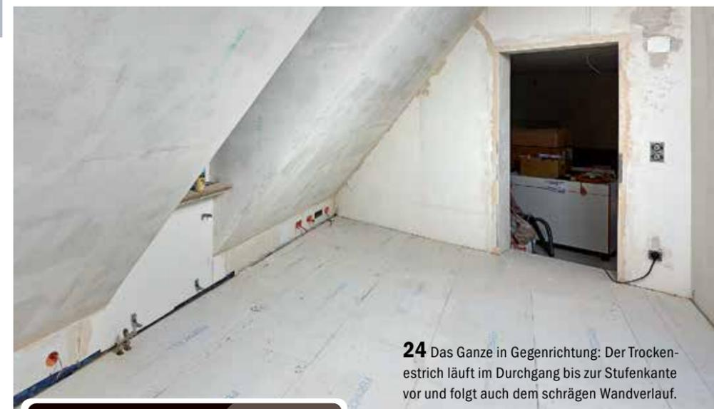
**24** Das Ganze in Gegenrichtung: Der Trockenestrich läuft im Durchgang bis zur Stufenkante vor und folgt auch dem schrägen Wandverlauf.
