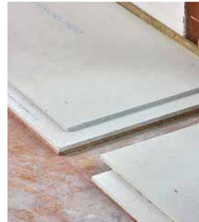
**8** Hier einmal der Stufenfalz im Detail: Die Überblattung sorgt für eine versatzfreie Oberfläche und ermöglicht eine stabilisierende Plattenverbindung.
