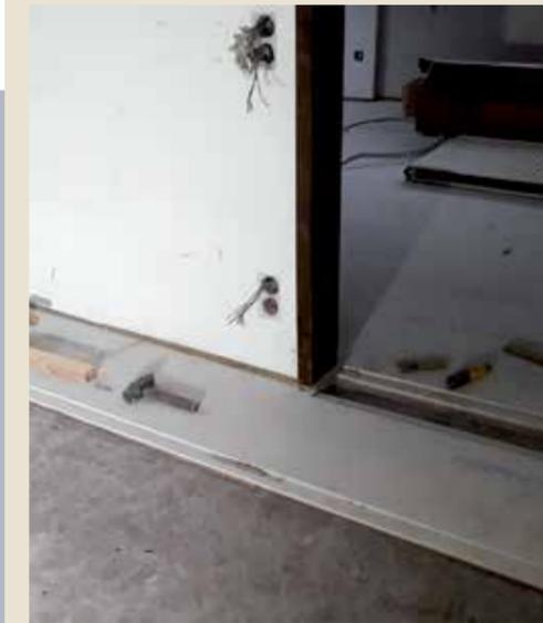
**A** Wenn Estrichelemente von einem bereits ausgelegten Raum in einen angrenzenden Raum durchgängig weiter verlegt werden, löst man das Anschluss-Problem am besten innerhalb des Türdurchgangs. Im nächsten Raum beginnt man parallel zur Wand, wobei auch hier der wandseitige Stufenfalz abgesägt wird.
