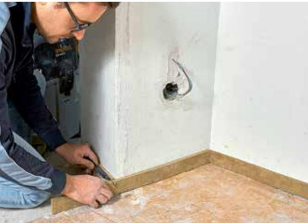
**6** Bevor jedoch das erste Estrich-Element verlegt wird, stellt man noch die 5 cm hohen und 1 cm dicken Streifen aus Mineralwolle als schalltrennende Randdämmung auf.
