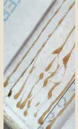
**F** Verklebt wird dieses mit dem Spezialkleber. So ist ein schwimmender Plattenverbund hergestellt sowie ein versatzloser Übergang.
