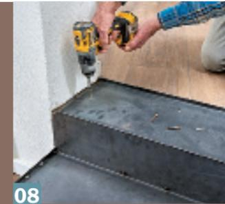
**08** Mit drei Schrauben (durch den Trockenestrich bis in den Untergrund) an zuvor vorgebohrten und angesenkten Löchern wird die Treppe gesichert.
