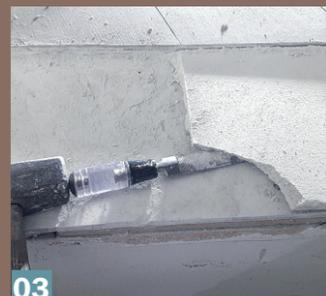
**03** Die obere 10 mm dicke Plattenlage hebt man am besten mit einem starren Werkzeug (zum Beispiel einem Stechbeitel) und einem Hammer ab.
