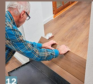
**12** Das nächste Element wird hinten abgesägt (Wannenrand) und dann mit dem bereits liegenden verklebt, flachgelegt und ins Kleberbett gedrückt.
