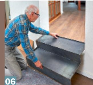
**06** ... eingebaute Stahlkonstruktion. Die obere Tritttiefe entspricht der Mauerdicke, unten hat man 33 cm gewählt. Die Stufenhöhe wurde vermittelt.
