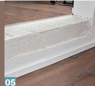
**05** Oben und unten derselbe Bodenbelag, die Sockelleiste läuft durch und der Wandputz ist aufgetragen und lässt entsprechenden Platz für die nun ...
