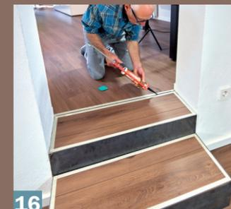
**16** Nach Aushärtung des Klebers verfüllt man die Fugen zwischen Belag und Stahlrand mit Silikon (hier in Schwarz), die Fugen zum Putz mit weißem Acryl.
