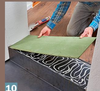
**10** ... Plattenstück aus verpressten Pappelholzfasern einlegen. Der Kleberauftrag erlaubt ein leichtes Eindringen in die Wanne, sodass beim Einlegen ...
