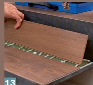
**13** Dasselbe passiert an der unteren Stufe. Hier beginnt man mit einem gleich breiten Element wie oben und ergänzt dann mit einem Schmalstück.
