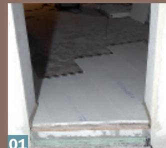
**01** Der obere Raum liegt um zwei Stufen höher. Die Estrichelemente werden bis zur vorderen Kante verlegt und bilden einen stabilen Untergrund.
