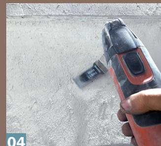
**04** Restliche Unebenheiten und Kleberpunkte des Trockenestrich-Elements raspelt man ab oder trägt sie wie hier mit dem Sägevorsatz ab.
