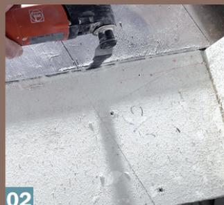
**02** Wenn dann der Dielenboden verlegt ist (bis zur hinteren Laibungskante), kann man den Estrich entlang der Belagskante 10 mm tief abtrennen.
