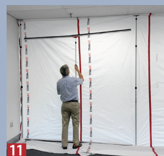
07 Damit nun am Fußboden Dichtigkeit herrscht, wird das Bahnenmaterial unter jeden Fußpunkt geschoben und glatt gezogen.
