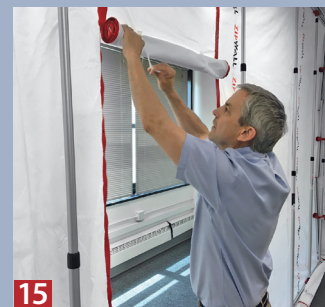
11 Die so bestückte Teleskopstange wird nun mittig zwischen den schon fixierten Stangen aufgestellt, hochgeschoben und fixiert.
