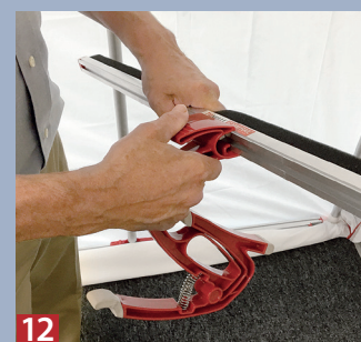
08 Um Dichtigkeit an der Decke zu gewährleisten, zieht man die Schienenelemente („Foam Rail Span“) auseinander und ...
