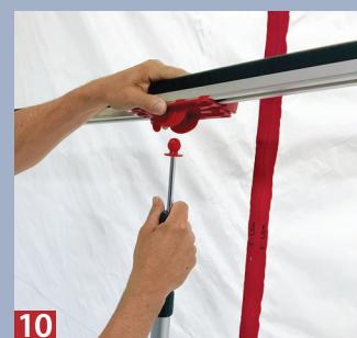
06 Stets beachten, dass unten das Bahnenmaterial nicht eingeklemmt wird. Auch die letzte Stange wird wandnah platziert.
