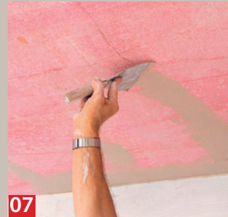
03 Die verfüllte Fehlstelle gleich mit einer Spachtel oder Glättkelle glätten. Auch Risse und kleinere Macken kann man so beseitigen.
