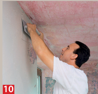
06 Muss großflächig repariert werden, zieht man die Wand mit einem Flächenspachtel, eventuell auch in mehreren Schichten, ab.
