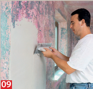
05 Bei Tapezier- oder Anstricharbeiten stören selbst kleine Unebenheiten. Sie können mit einem Flächenglätter egalisiert werden.
