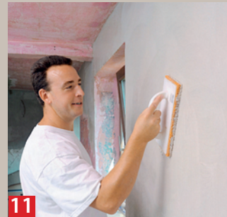
07 Fehlstellen an Decken werden entsprechend behandelt. Überstehende Spachtelreste nach Durchtrocknung abschleifen.
