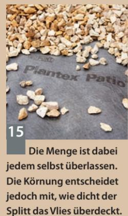
**15** Die Menge ist dabei jedem selbst überlassen. Die Körnung entscheidet jedoch mit, wie dicht der Splitt das Vlies überdeckt.
