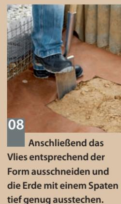
**08** Anschließend das Vlies entsprechend der Form ausschneiden und die Erde mit einem Spaten tief genug ausstechen.
