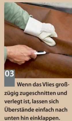
**03** Wenn das Vlies großzügig zugeschnitten und verlegt ist, lassen sich Überstände einfach nach unten hin einklappen.
