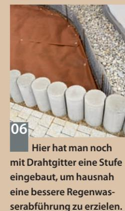
**06** Hier hat man noch mit Drahtgitter eine Stufe eingebaut, um hausnah eine bessere Regenwasserabführung zu erzielen.
