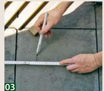
**03** Die Lage der Unterzüge wird auf den alten Betonplatten angezeichnet. Der Lattenabstand beträgt maximal 45 Zentimeter.
