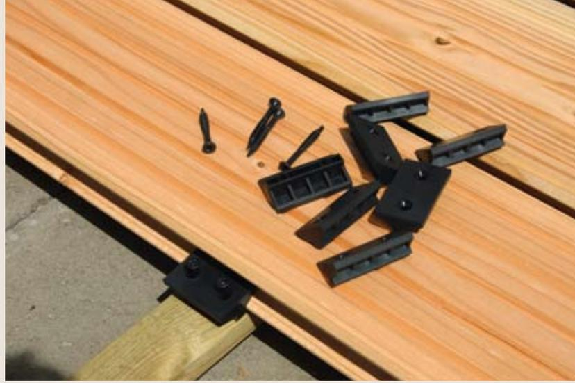
Die Terrassendielen haben seitlich V-förmige Nuten für die Aufnahme der Kunststoffclips. Dank ihrer konischen Form halten diese die Dielen zur Unterkonstruktion auf Spannung.
