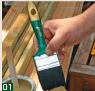
**01** Die druckimprägnierten Unterzüge für den Holzbelag werden an den Schnittstellen mit einem Holzschutz behandelt.
