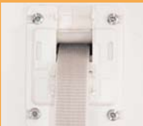
Bohrpunkte für den Grundrahmen bestimmen, Schutzfolie abziehen und Element über die alte Öffnung setzen.
