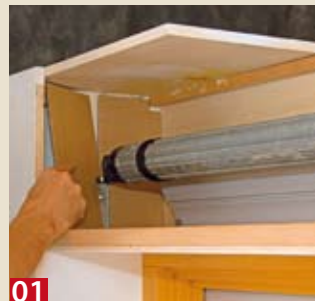
01 Mit Hilfe von Kartonschablonen ermittelt man Größe, Form und Ausschnittsituation für die Seitenwanddämmungen.
