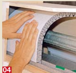
02 Diese mit zwei Dämmteilen ausführen. Die Fuge zwischen den beiden Längenelementen wird dann mit Klebeband abgedichtet.
