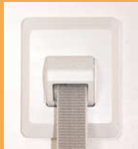
Die neue Optik: Das alte hässliche zugige Gurtloch ist abgedichtet und sieht deutlich eleganter aus als vorher.
