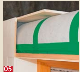
03 Die flexibel zu biegenden Dämmschalen werden im oberen Bereich mit Kleber versehen. Hier geht man in drei Abschnitten vor.
