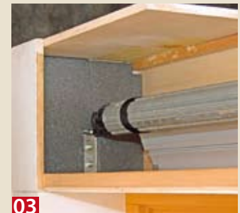
03 Zur besseren Einsicht haben wir unseren Demo-Rollladenkasten vorne geöffnet. So sieht man die Seitenwanddämmung besser.
