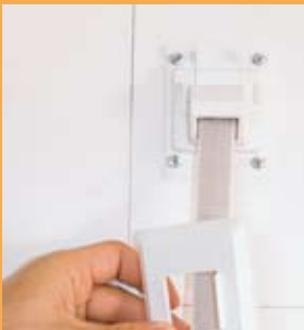
Zuletzt die Abdeckblende über den Gurt fädeln und auf den Grundrahmen klipsen. Die Schrauben verschwinden.
