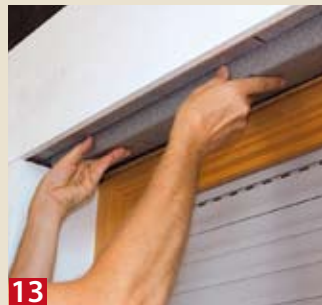
09 Dieselbe Vorgehensweise auf der anderen Seite, wobei hier der Gurtdurchgang aus der Dämmung herausgeschnitten werden muss.
