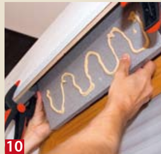
06 Falls eine Fuge zwischen dem Dämmteil und der Wandauf-lage bleiben sollte, diese noch mit Kle-ber bzw. Schaum abdichten.
