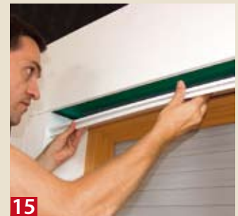
11 ... mit der Rückseite der Frontplatte des Rollladenkastens verklebt und mit Zwingen bis zur Aushärtung fixiert werden.
