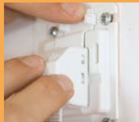
Bürstendichtung aufsetzen. Alle Verbindungen müssen einrasten. Die Bürsten drücken den Gurt an die neue Rolle.
