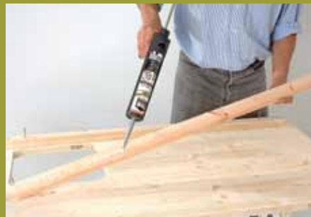
10. Die Arbeitsplatte erhält einen Beckenausschnitt und längs zwei Verstärkungshölzer.
