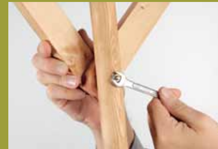
14. Dank durchgesteckter metrischer Schrauben und Muttern ist das Dach demontierbar.
