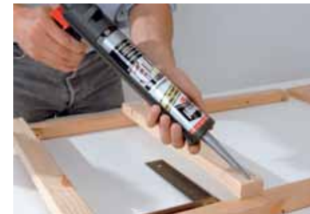
3. Wo Holz auf Holz trifft, wird zusätzlich ein Konstruktionsklebstoff aufgetragen. Die ...
