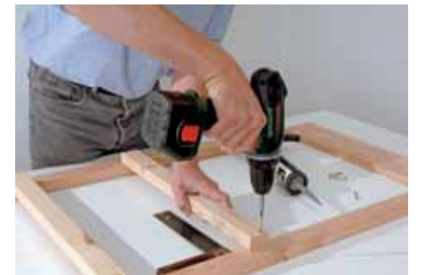
4. ... Querleisten werden nach innen versetzt an die Pfosten des Seitenelementes geschraubt.
