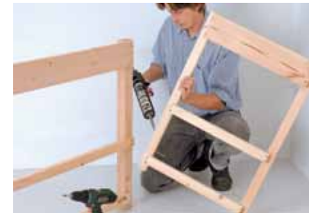
5. Die Längs- und Seitenteile werden verbunden: Kleber auftragen, etwas abbinden lassen ...
