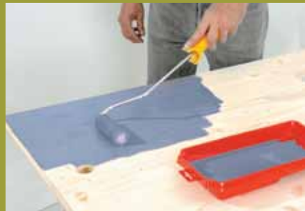
13. Die Arbeitsplatte wird vor der Montage zweimal rundum mit Zwischenschliff lackiert.
