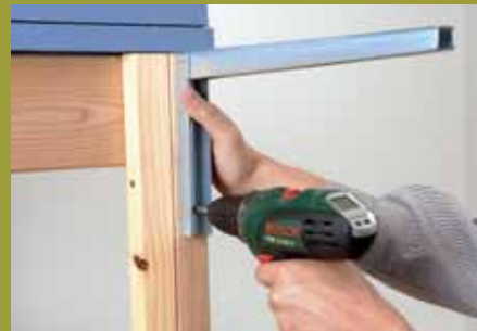
13. Für die Tischverbreiterungen werden zwei-mal zwei einfache Klappkonsolen montiert.
