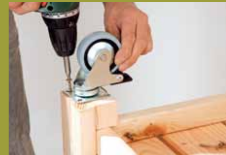
9. ... Profil. Daran werden die Montageplatten der feststellbaren Lenkrollen geschraubt.
