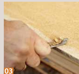
03 ... keine Spachtelkante ab- weist, muss hier der Bereich mit einer Klinge entsprechend be- arbeitet werden (40 x 1,5 mm).
