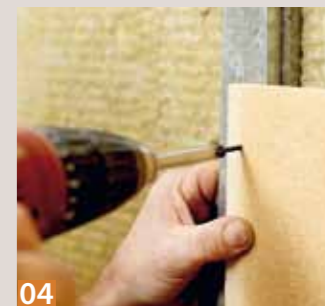
04 Die Lehm- bauplatten lassen sich mit handelsüblichen Schnell- bauschrauben, zum Beispiel an Wandprofilen, befestigen.
