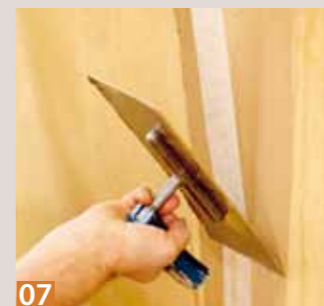
07 ... und nochmals mit Lehm- spachtel überarbeitet. Mit dem Stahlglätter wird der Spachtel dabei auf Null abgezogen.
