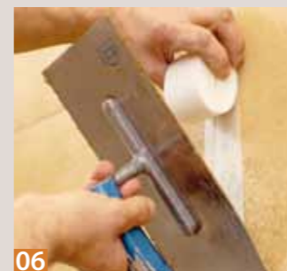
06 Über den ausgespachtelten Plattenstößen werden Gitter- Bewehrungsstreifen von der Rolle angebracht ...
