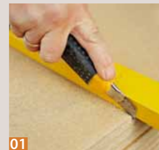
01 Zur einfachen Konfektionie- rung auf der Baustelle werden die Biopan-Lehm- bauplatten zum Bei- spiel mit einem ...
