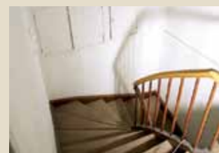
Blick vom 2. OG hinunter ins Treppenhaus. Hinter der Stirnwand befindet sich das alte Bad. Von dem aus sollte die neue Treppenanlage beginnen und in halber Höhe des Treppenhauses einmünden.
