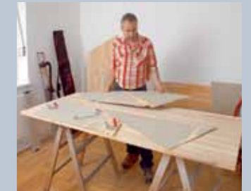
3. Die fertigen Pappstufen ordnete man dann materialsparend auf den Buchenplatten an.
