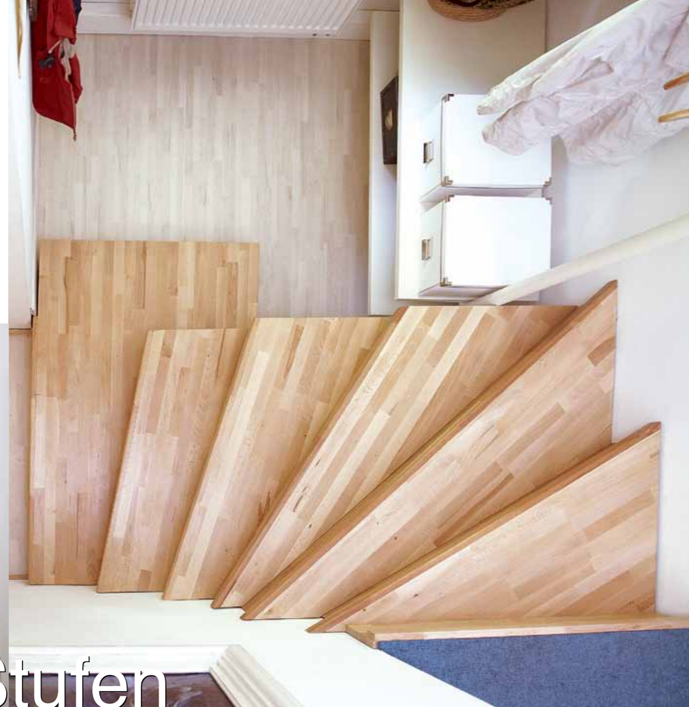
1. Anhand der Rohbaumaße ermittelte man zuerst die Abmessungen der späteren Tritte. Schablonen ...
