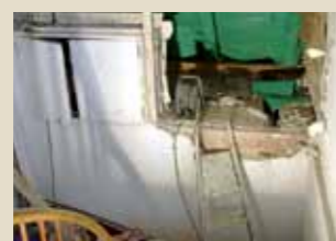
Nach dem Wanddurchbruch stieß man auf die Baddecke, die ebenfalls entfernt wurde. Der Querbalken legte das Niveau fest, ab dem der neue Treppenabgang ins darunterliegende Geschoss führt.
