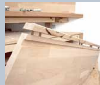
23. Die Leisten wurden ebenfalls per Runddübel mit den Stufenplatten verbunden bzw. verleimt.
