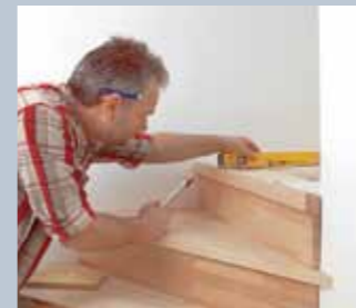
20. Die letzte Stufe mit Stellbrett liegt, als überstehende Kante hat man hier eine Leiste aufgeleimt.
