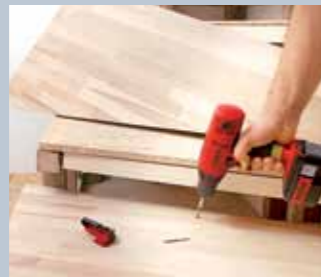
10. Die Stufen hat man nun hinten auf dem Unterbau angeschraubt, um sie herunterzudrücken und ...
