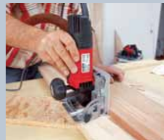
15. Mit der Lamellofräse schlitzte man nun vier- bis fünfmal senkrecht in die Stufenplatte ein.
