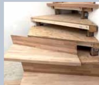
24. Die zusammengebauten Stufenwinkel wurden von unten nach oben auf der Rohrtreppe verklebt.
