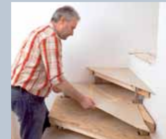
2. ... aus Pappesorgten dafür, dass man exakte Rohlinge hatte, die auch noch korrigierbar waren.
