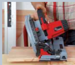
18. Vor dem Einleimen sägte man die Stellbretter wandseitig entsprechend des Winkels schräg ab.
