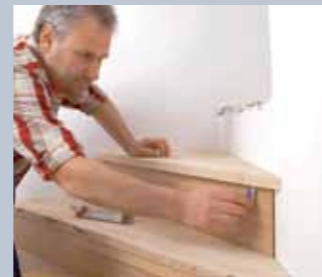
12. Setzstufen vorn etwas anheben, Stellbretter einschieben und die Vorderkanten unten anreißen.
