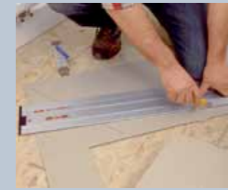
1. Anhand der Rohbaumaße ermittelte man zuerst die Abmessungen der späteren Tritte. Schablonen ...
