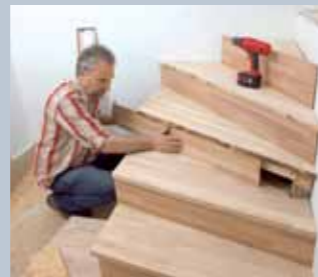
11. ... die Höhe der Stellbretter ermitteln zu können. Die Schrauben werden von diesen verdeckt.
