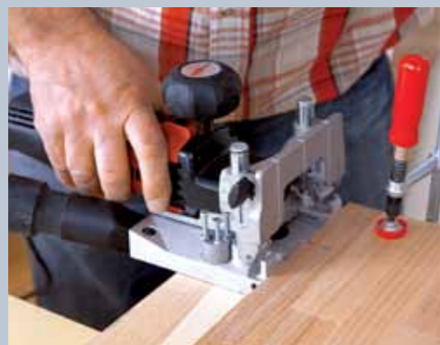
13. Denn an den Unterseiten der Stufenüberstände werden Nuten für die Stellbretter eingefräst.
