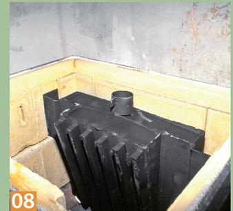
**08** Nach dem dritten Element wird der Wärmetauscher eingebaut. Er sitzt an der Rückwand – anstelle einer Speicherplatte.
