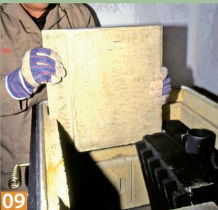
**09** Seitlich und vorne wird der Ofen innen mit weiteren Wärmespeicherplatten ausgestattet. Diese sind passgenau vorgefertigt.
