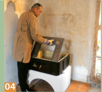
**04** ... erste Ofen-Ringelement dicht ansetzen lässt. Im nächsten Schritt legt man gleich auch schon die eiserne Bodenplatte ein.
