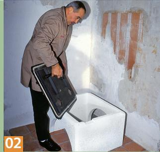
**02** Zuerst wird das verputzte Sockelteil aufgestellt und exakt ausgerichtet, dann verlegt man auch schon die Grundplatte.
