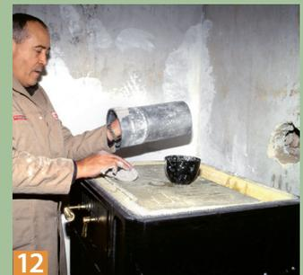
**12** ... bohrt man die Öffnung aus, kittet das Rohrende ab und baut das Verbindungsrohr ein. Nun Ring vier wieder aufsetzen.
