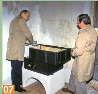
**07** Mit einer Setzhilfe lässt sich dann das nächste Element leicht aufbauen. Darauf achten, dass es versatzfrei und dicht aufliegt.
