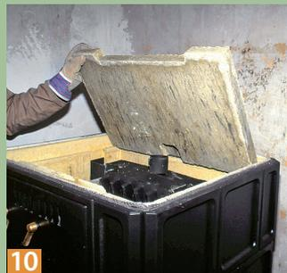
**10** Die Brennkammer deckt nun eine entsprechende Speicherplatte ab. Sie liegt einfach lose auf der inneren Auskleidung auf.
