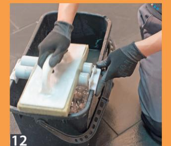
**12** ... werden – erst mit kreisenden Bewegungen, dann flächig. Das Waschbrett laufend reinigen und das Wasser erneuern.
