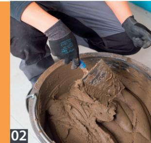
**02** Dann wird schnell trocknender Natursteinkleber für die Dünnbettverlegung in einer nicht zu großen Menge angerührt.
