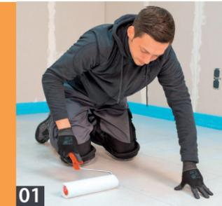
**01** Zuerst wird der ebene, rissfreie und trockene Estrich grundiert. Dadurch wird seine Saugfähigkeit reduziert.
