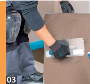
**03** Eine dünne Schicht des Fliesenklebers auf die Rückseite der Fliese aufgebracht verbessert die Haftung im Kleberbett.
