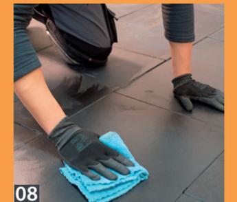
**08** ... mörtels lassen sich dann leichter entfernen. Überschüssiges Imprägniermittel wird mit einem fusselfreien Tuch abgewischt.
