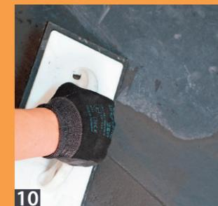
**10** Den Fugenmörtel mit einer oberflächenschonenden Gummikelle diagonal zum Fugenraster auftragen und einarbeiten.
