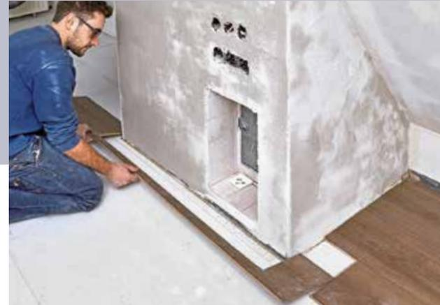
**13** Wandvorsprünge lassen sich durch exaktes Zusägen elegant umlegen – selbst mit schmalstem Steg.
