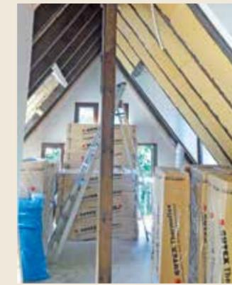
**C** Eine Holzfaserdämmung füllt die Balkenräume, Gipsfaserplatten dienen als Beplankung. (B&R-Heft 5/6-18)
