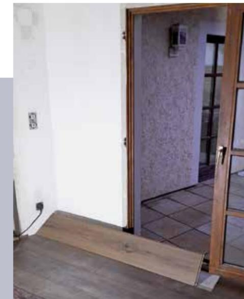
19. Zum möglichen Eindrehen und Verriegeln dieser ersten Diele der letzten Reihe musste zuvor kurz noch einer der zwei Terrassentürflügel ausgehängt werden.
