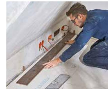
**3** Die schmale Diele liegt dann mit Abstandshaltern an der Kniestockwand an. Sie wurde übrigens so lang gewählt, dass das nächste Element ...
