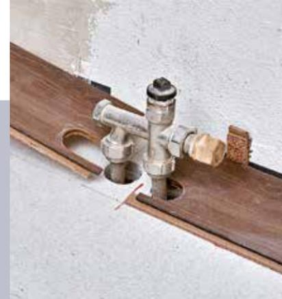
**9** Die folgende Diele bekommt einen ähnlichen Rundauschnitt und schließt dann am Querstoß über die Klickverbindung nahtlos an.
