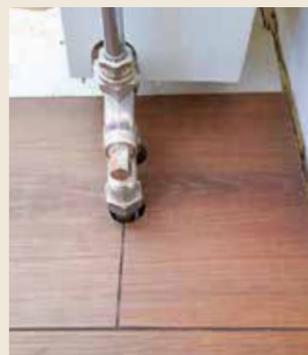
4. Problem gelöst: Längs wurde verleimt, am Querstoß die Original-Verriegelung.
