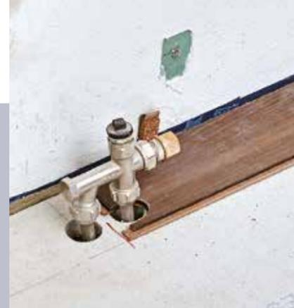
**8** Und so sieht die Rohrsituation dann aus. Das schmale Bodenelement liegt exakt an der zuvor ermittelten und angezeichneten Markierungslinie.
