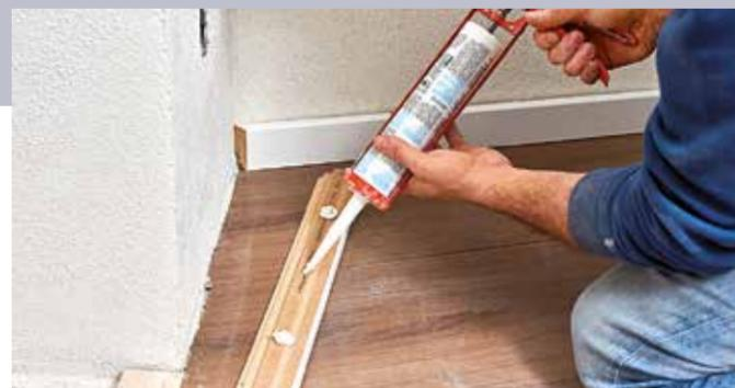
20. Da die Dielen mit Wandabstand (als Dehnfuge) verlegt werden müssen, lassen sich die Fugen später am besten mit Sockelleisten abdecken. Einzelne Kleberpunkte genügen, um die MDF-Leisten an der Putzwand zu halten.
