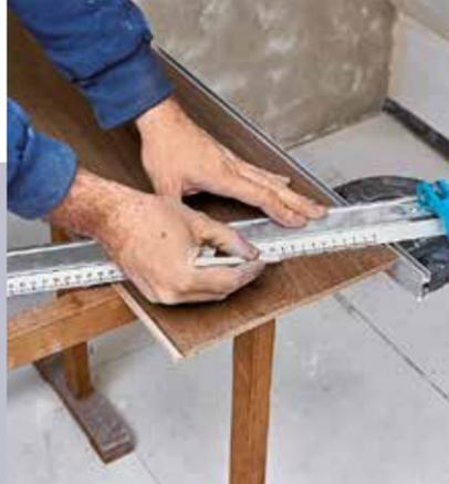
**10** Da eine Raumwand schräg verläuft, übertrug man den Winkel auf die Dielenanfänge und sägte so ab.
