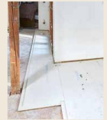
**D** Mit neuem Estrichboden wird der Trittschall optimiert und ein ebener Untergrund erstellt. (B&R-Heft 7/8-18)
