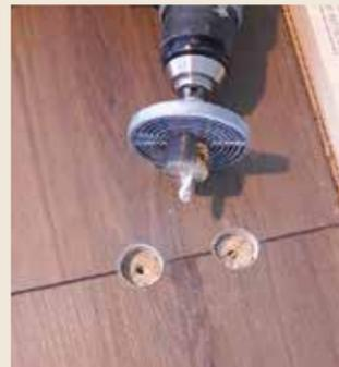
1. Rohrdurchgänge mit der Lochsäge über beide Dielen hinweg freisägen.
