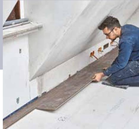
**12** Die Dielen lassen sich durch schräges Ansetzen längsseitig in die Nut eindrehen. Dann klappt man sie nach unten und drückt sie am Kopfende zusammen.
