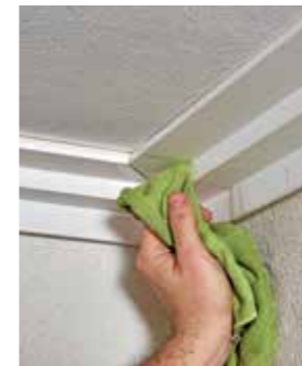
19 Den Überschuss nimmt man am besten dann ab, wenn der Kleber noch nicht ausgehärtet ist, und die Profiloberfläche kann dann auch mit Aceton abgewischt werden.
