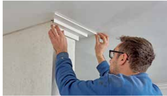
7 Das stirnseitige Passtück nun probeweise einmal hinhalten und die Gehrungsschnitte prüfen. Kleine Unstimmigkeiten lassen sich später beim Verkleben ausgleichen.
