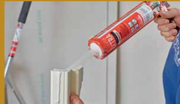
14 Und so verbindet man die Profilstöße bzw. Gehrungsanschlüsse. Der transparente Kleber wird an einem Profilenende ebenfalls durchgängig aufgetragen.
