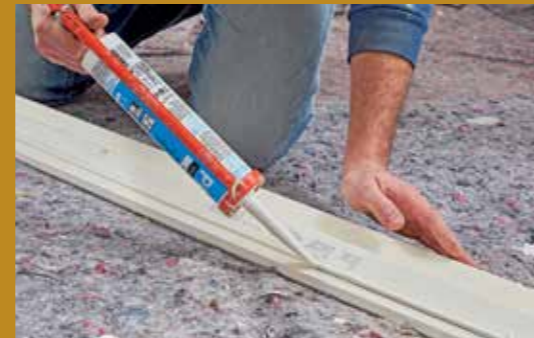
13 Nun kann das vorbereitete Langprofil mit Kleber versehen werden. Damit die Sichtseite nicht verkratzt wird, empfiehlt sich eine weiche Unterlage.
