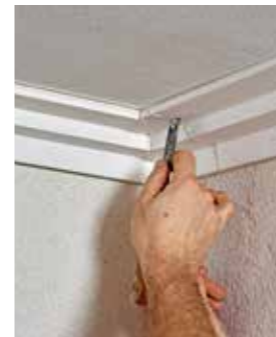
19 Den Überschuss nimmt man am besten dann ab, wenn der Kleber noch nicht ausgehärtet ist, und die Profiloberfläche kann dann auch mit Aceton abgewischt werden.
