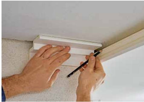
5 ... wie oben. Diese zwei Endpunkte an den beiden Leistenkanten sind dann die Verbindungspunkte für den Zuschnitt – zum Beispiel an der Gehrungssäge.
