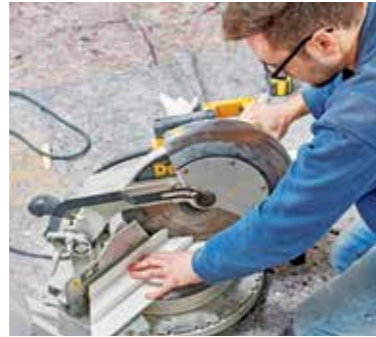
6 Diese exakt einstellen und das Zierprofil entsprechend anlegen. Der Kunststoff lässt sich ausrissfrei durchtrennen.
