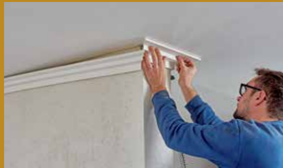
12 ... die Zierleisten sicher an Decke und Wand. Der Gehrungsanschluss wird mit einem transparenten Kleber sichergestellt. Durch Andrücken kann die Verbindung noch korrigiert werden.
