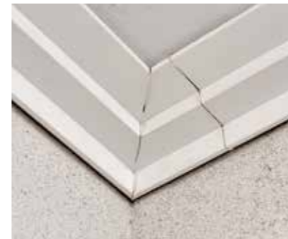
18 Der Kleber darf durchaus austreten. Hier sieht man auch, wie unten und oben eine Schattenfuge bleibt.
