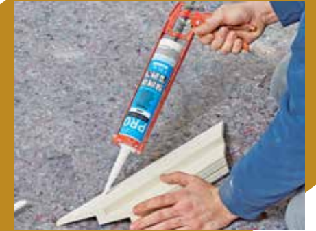
10 Jetzt geht es ans Verkleben: Die Profile weisen Nuten auf, in die dann eine Kleberspur aufgetragen wird – hier am deckenseitigen Schenkel.
