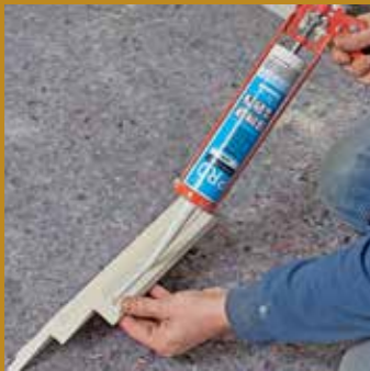
11 Die Kleberspur darf über den Nutrand hinaustreten und sollte durchgängig sein. Der weiße Kleber hält ...
