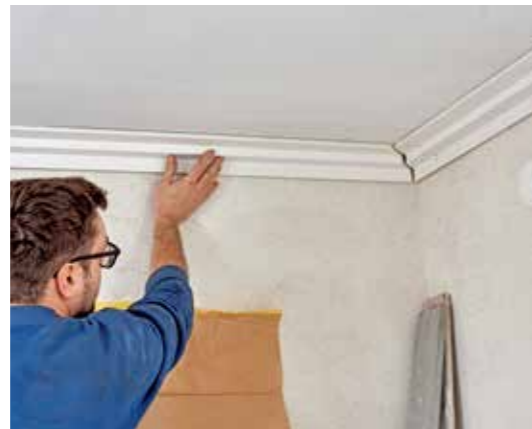
17 ... das erste 2-Meter-Profil der Anschlusswand passgenau an und wird im Gehrungsbereich ebenso mit dem farblosen Kleber verbunden.
