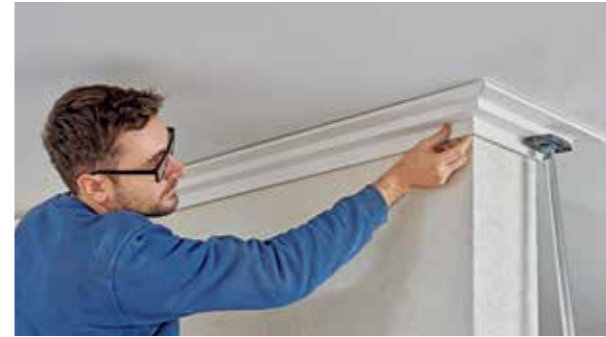
8 Wenn das Passtück mit einer Stütze fixiert ist, kann man das nächste Langprofil zuschneiden und probeverlegen. Da die maximale Profillänge 2 m ist, muss man evtl. auch einmal ...
