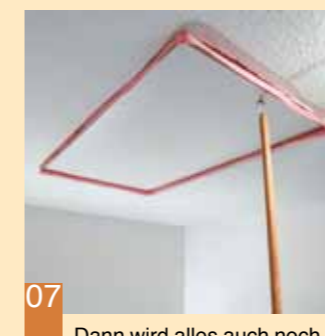
03 ... den Deckenausschnitt gezogen und an der Deckenunterkante mit einem Dampfbremsschicht Klebeband sauber abgeklebt.
