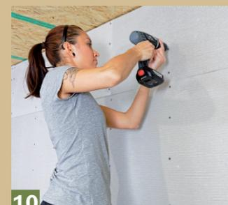
**10** Die letzte Platte wird befestigt. Jeweils nicht zu fest schrauben. Der Schraubenkopf soll bündig mit der Plattenfläche abschließen.
