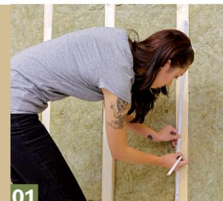
**01** Man beplankt von unten nach oben. In Plattenhöhe plus 5 mm Zugabe, also bei 80,5 cm setzt man eine Markierung an eine mittlere Latte.
