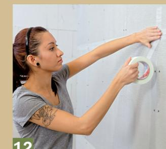
**12** Mit einem selbstklebenden Gewebeband werden abschließend die Fugen kaschiert. Dann kann die Wand direkt verputzt oder verfliesen werden.
