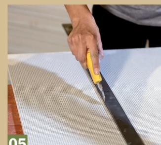
**05** ... Winkel eine Linie ziehen. Dann entlang des Winkels die Platte zuschneiden. Dabei einen Cutter mit neuer, scharfer Trapezklinge verwenden.
