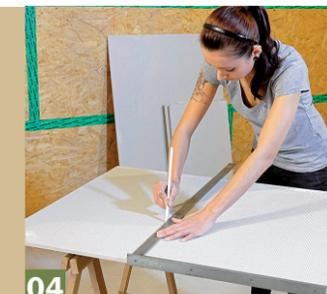
**04** Um Kreuzfugen zu vermeiden, die erste Platte der zweiten Reihe so zuschneiden, dass ein Versatz entsteht. Also abmessen und per ...
