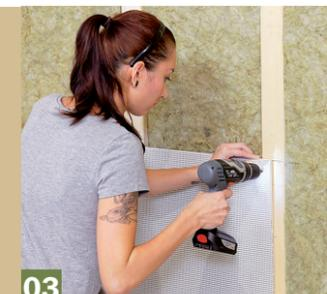
**03** Die erste Blähglasplatte ausrichten und mit Schnellbauschrauben im 25-cm-Abstand mittig an die Latte schrauben.
