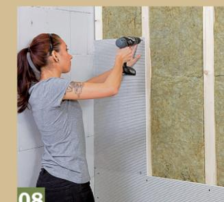
**08** Zweite Reihe von unten: Die Holzunterkonstruktion wird zunächst mit dem Zuschnitt bekleidet, dann folgen wieder ganze Platten.
