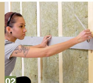
**02** Mit Hilfe einer Wasserwaage oder eines Richtscheites überträgt man den Höhenriss über die gesamte Breite auf alle senkrechten Holzlaten.
