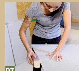
**07** ... anschließend das Gewebe auf der Plattenrückseite durch. Die Schnitt- bzw. Bruchkante wird per Schleifklotz nur leicht geschliffen.
