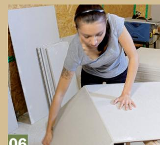
**06** Nun wird die Leichtbauplatte – am besten über eine Kante – abgeknickt und gebrochen. Danach dreht man sie um und trennt ...
