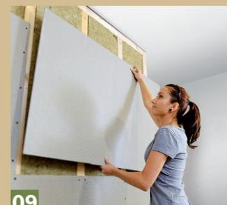
**09** Mit Leichtigkeit lassen sich auch die ganzen Blähglasplatten in der Höhe und über Kopf ausrichten und an den Laten montieren.
