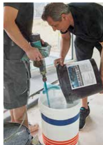
3 Dann schüttet man den Grundspachtel langsam und kontinuierlich in den Wassereimer ein und mischt zugleich alles gut per Rührgerät auf.
