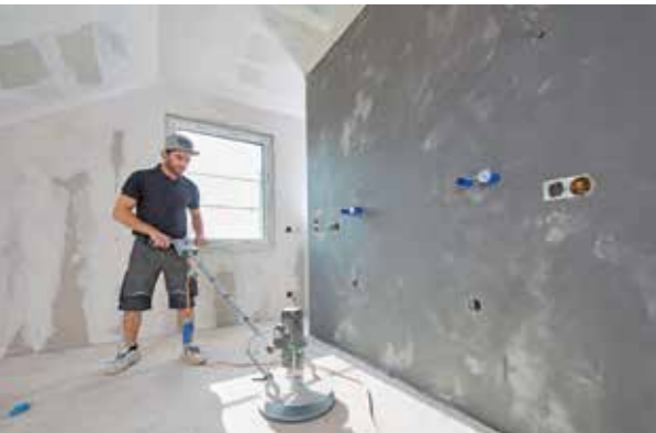
9 Während die gespachtelten und verpressten Wände austrocknen, bereitet man schon den Boden vor. Je nach dessen Zustand kann auch ein Abschleifen erforderlich sein.
