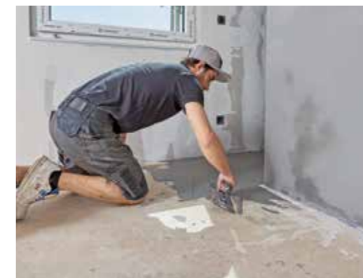
13 Aus der Dusche heraus wird der eigentliche Badboden in einem Zug durchgespachtelt. Mit der Masse lassen sich auch kleine Unebenheiten ausgleichen. Der Auftrag sollte jedoch zwei Millimeter Schichtdicke nicht überschreiten.
