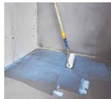
16 Die Imprägnierung wird am einfachsten mit einer Fellrolle aufgetragen. Dabei die Bahnen nass in nass ineinanderlaufen lassen.
