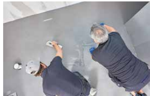
14 Zweiter Auftrag wie an der Wand. Zu zweit ist das Verteilen und Verpressen deutlich besser und zeitsparender zu bewerkstelligen.
