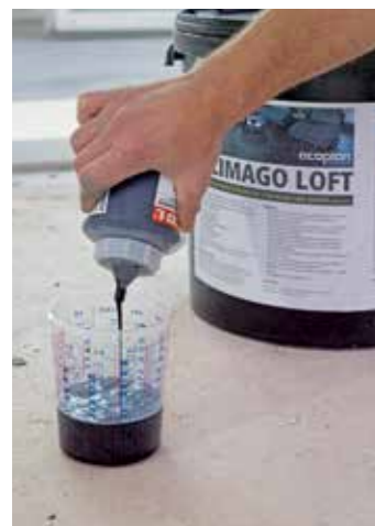
1 Mit einem Flüssigpigment lässt sich die Spachtelmasse individuell einfärben. 100 ml pro Gebinde ergeben eine 4-prozentige Einfärbung. Hier hatte ...
