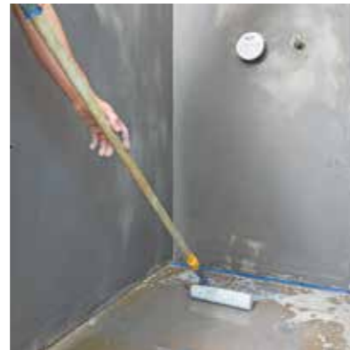
10 Aus dem hintersten Eck heraus – oder wie hier von hinten aus der Duschnische – beginnt der Grundrievorgang des Rohbodens.
