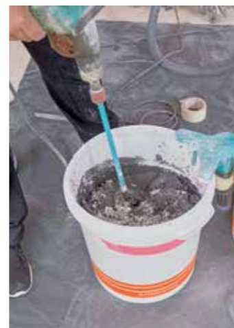
4 Nach dem ersten Mischvorgang die Masse ein paar Minuten stehen lassen, dann noch einmal durchquirlen. Es sollten keine Trockennester übrigbleiben.
