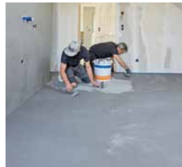
15 Und so arbeitet man sich schließlich aus dem Raum hinaus. Der Trocknungsvorgang bis zum nachfolgenden Versiegeln dauert dann mindestens 24 Stunden.
