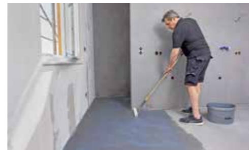
17 Hier sieht man gut, wie aus der Dusche heraus der Boden bearbeitet wird. Nach 24 Stunden ist auch die Wand ausreichend ausgetrocknet, ...
