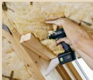
Hilfshölzer für die nachfolgende GK-Beplankung anschrauben.
