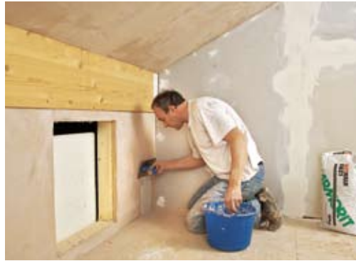
39. Dann kann der Oberputz aufgetragen werden. Hier ein Filzputz mit Körnung 1, der eine feine Struktur ...
