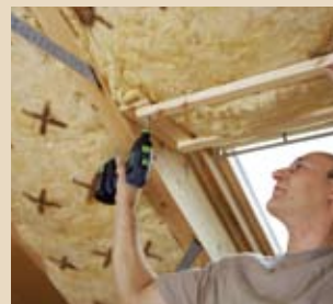
Latten dienen dann ebenfalls zur Verschraubung der GK-Platten.
