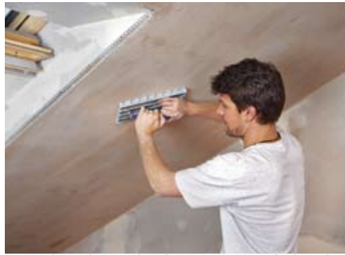
37. Nach Trocknung der glattgezogenen Schicht reibt man noch mit einem Gitterrabbot kreisförmig nach.
