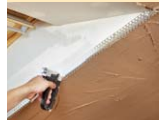
So kann man die Bauplatte einschieben und winkelig abklappen. Die Kartonbeschichtung muss bleiben!
