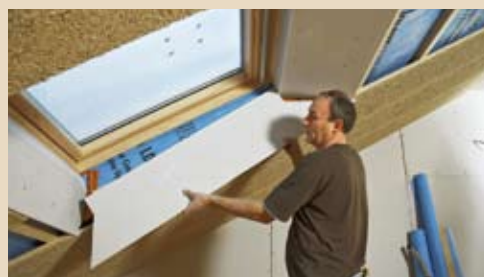
Die Seitenteile werden passgenau zugeschnitten, eingepasst und seitlich auf Traghölzern verschraubt.
