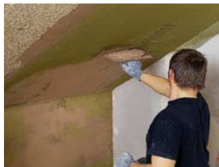
35. Wenn das Gewebe aufgelegt worden ist, zieht man nass in nass eine zweite Lage über.
