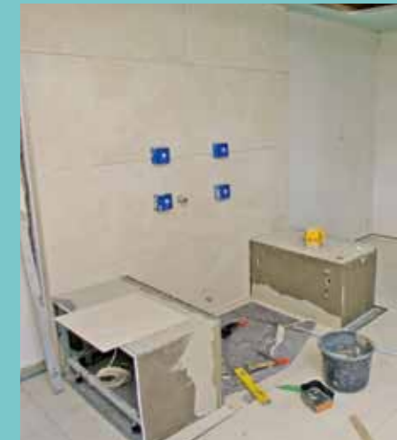
5. Rückwand sowie Sitzbänke erhielten eine Bekleidung aus modernen, großformatigen Natursteinplatten.
