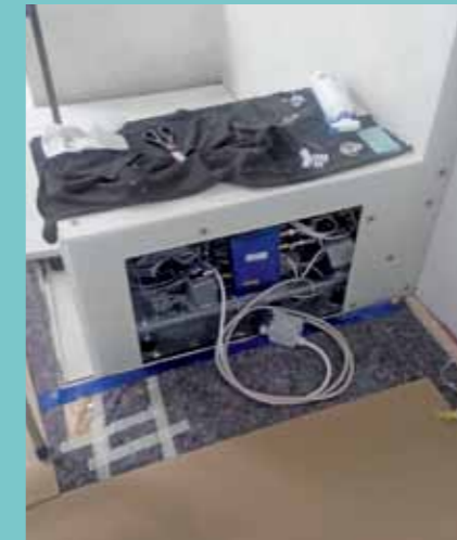
4. Im Hohlkörper der rechten Sitzbank konnte somit auch die ganze Dampftechnik platzsparend untergebracht werden.
