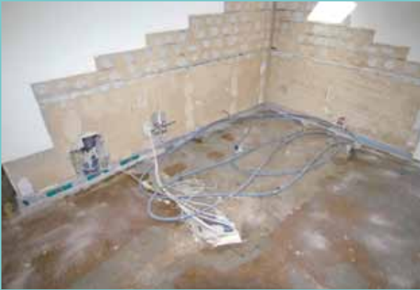
9. Am Standort der alten Wanne wurden die gestuft verlegten Wandfliesen und das gesamte Podest entfernt sowie die Strom- und Wasserleitungen für die Whirlwanne vorbereitet.
