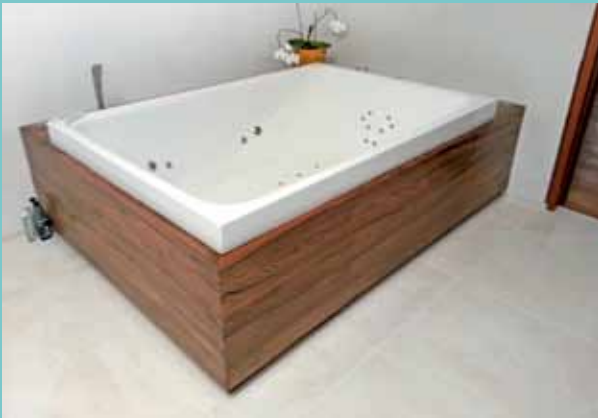
11. Etwas von der Wand abgerückt konnte die Wanne elegant mit einer Holzverkleidung umrahmt werden, wobei eine zusätzliche ...
