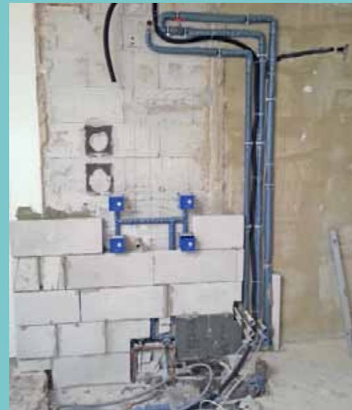
2. Damit später alles als Inwandmontage ausgeführt werden konnte, hat man die Leitungen mit 5 cm dicken Porenbetonsteinen eingemauert und somit auch eine ebene Verfliesfläche geschaffen.
