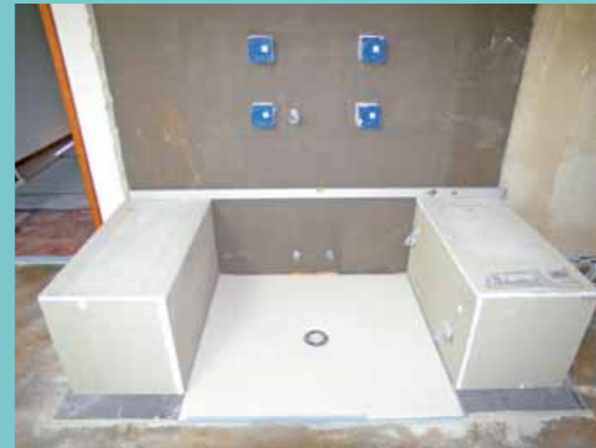
3. Die Sitzbänke wurden ebenfalls auf Wunschmaß gefertigt und mit Bauplatten befliesfähig aufgebaut. Als Duschboden fungiert eine flache Stahlemail-Duschtaße mit Mittenablauf.
