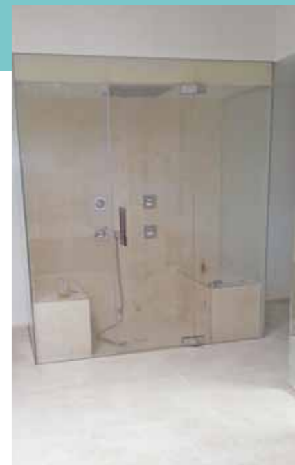
8. Zugänglichkeit zur Technik ermöglicht eine Glasblende, die harmonisch in die Gesamtansicht eingebunden ist.
