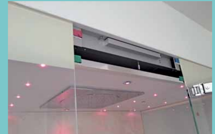
8. Zugänglichkeit zur Technik ermöglicht eine Glasblende, die harmonisch in die Gesamtansicht eingebunden ist.
