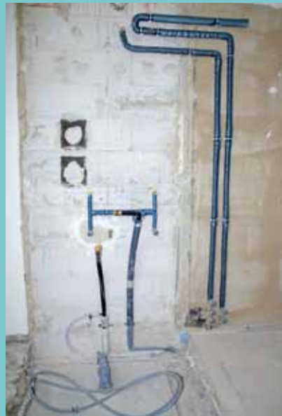
1. Am Platz der alten Dusche wurden für die geplante Dampfdusche die Rohrleitungs-führung abgeändert und die neuen Armatur-Punkte vorbereitet.
