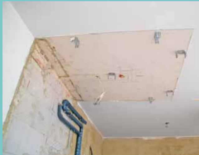
6. An der Decke bereiteten die Installateure die Montage für den Duschkabinenhimmel vor. Hier wurde eine individuelle Lösung erarbeitet.
