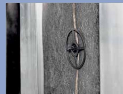
4. Dämmstoffhalter sichern die Dämmung dann gegen Verrutschen. Anschließend wurden die ...
