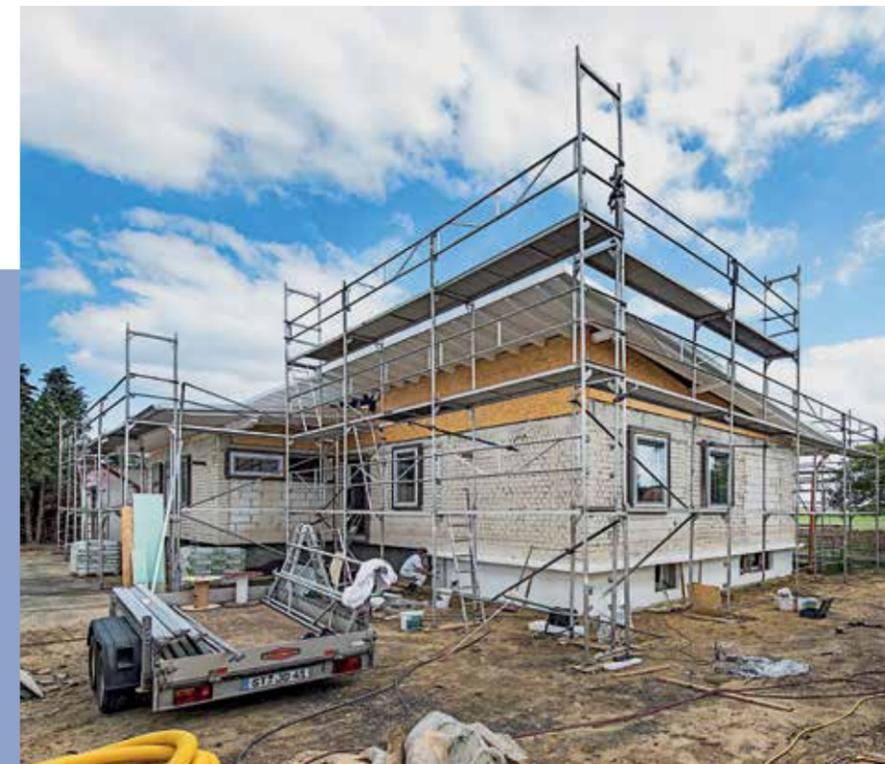
1. Neues Pultdach mit Wanderhöhung und Dachüberstand, neue Fenster, die nach vorne versetzt wurden und die freigelegten Kalksandsteinwände – die neue Fassade kann kommen.
