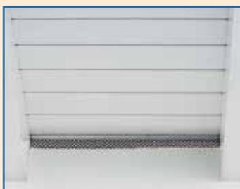
Die Lüftungsöffnung unterhalb des Dachs ist für die funktionsfähige Hinterlüftung der Vorhangfassade ebenfalls unerlässlich. Auch hier ist die Lüftungsöffnung mit einem Gitter versehen.
