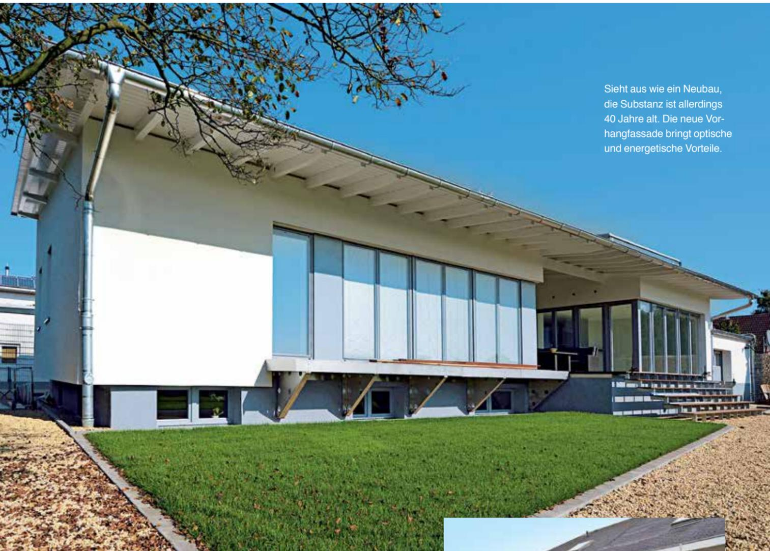
Sieht aus wie ein Neubau, die Substanz ist allerdings 40 Jahre alt. Die neue Vorgehängsfassade bringt optische und energetische Vorteile.
