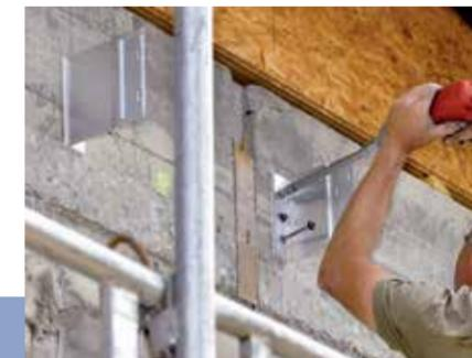
2. Die Wandhalter für die Profile wurden mit thermischen Trennelementen montiert.
