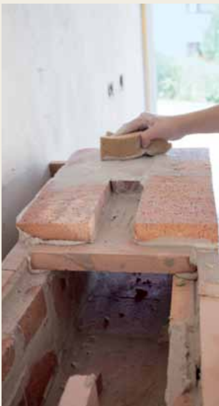
2. Die keramischen Züge werden individuell gebaut. Später gehen hier die heißen Heizgase durch und sorgen so auch für angenehme Strahlungswärme.
