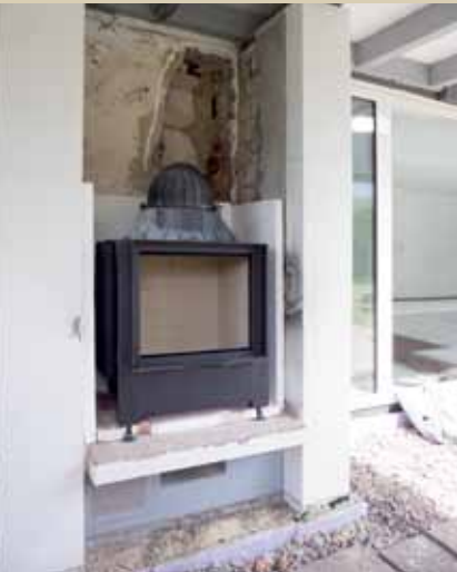
Nach dem Setzen des Heizeinsatzes zur Gartenseite hin wurden die angrenzenden Wände gedämmt. Damit wird verhindert, dass Hitze in die Wand zum Wohnzimmer einzieht.
