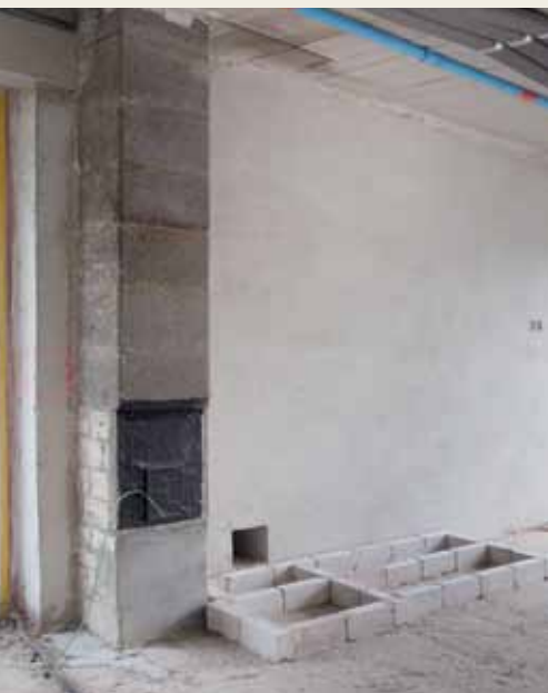
1. Noch in der Rohbauphase und bevor die Fußbodenheizung verlegt wird, erfolgt die Abmauerung des Sockels bis auf Höhe des späteren Estrichs.
