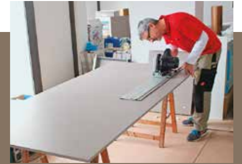
6. ... und mit der schienengeführten Handkreissäge herausgesägt. Dann kann die Platte probeweise an Ort und Stelle gebracht werden.
