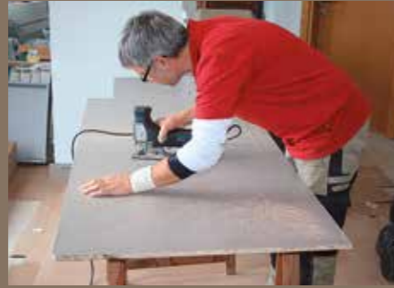
8. Die zweite Platte für die Fensterzeile gemäß der Fensterlaibungstiefe ausgeklinkt worden, jetzt wird noch der Spülenplatz ausgesägt.
