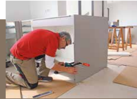
4. Alle später frei sichtbaren Korpusflächen erhalten farbgleiche Möbelplatten als Abdeckung. Auch diese sind bereits maßgenau vorgefertigt.
