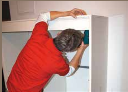
12. Die zwei Geräteschränke werden mit Hilfe von Dekorseiten und einer Abdeckung zu einer optischen Einheit zusammengefasst.
