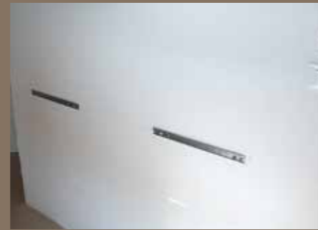
14. Sie hängt an zwei in einer horizontalen Linie ausgerichteten wandmontierten Stahlschienen. Zirkumaß der Anrichte: 1500 x 500 x 370 mm.
