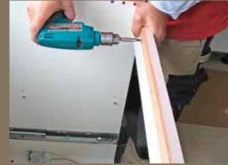
10. Am vorderen Rand des Spülenunterschrank beziehungsweise an der Querverstrebung wird ebenfalls eine massive Holzleiste angeschraubt.
