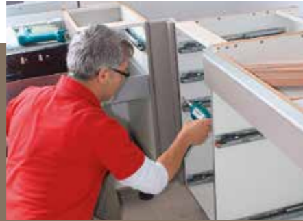
2. Die beiden Zeilenschenkel der L-Küche werden mit Hilfe eines vorgefertigten Winkelstücks mit Dekorblenden rechtwinklig verbunden.
