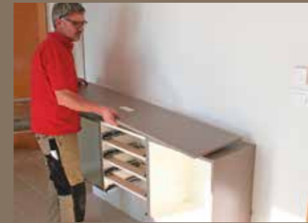
16. ... wird eine durchlaufende Abdeckplatte aufgelegt und von unten verschraubt. Die Optik entspricht der unserer Küchenarbeitsplatte.
