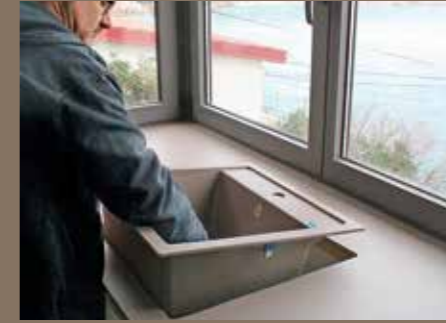
11. Das Mineralbecken wird eingesenkt und gespannt im Ausschnitt mit Spezialklammern. Eine Silikonabdichtung dichtet unterm Rand ab.
