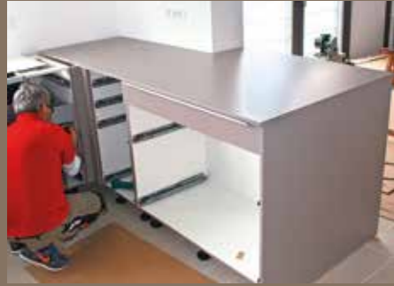
7. So sitzt die erste Platte perfekt im Raumeck – seitlich ohne Überstand und nach vorne nur so viel, wie es die Aluminiumgriffe vorgeben.
