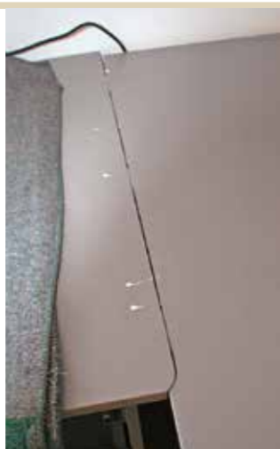
13. Aus zwei Oberschrankkorpusen und einer Zwischenverbindung aus 4 Einschubelementen wird die später frei hängende Anrichte gefertigt.
