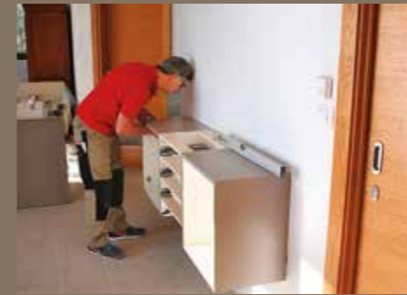
15. Mit entsprechenden Wandbeschlägen lässt sich das Hängemöbel noch exakt ausrichten. Um aus den 3 Elementen ein Möbel zu machen, ...
