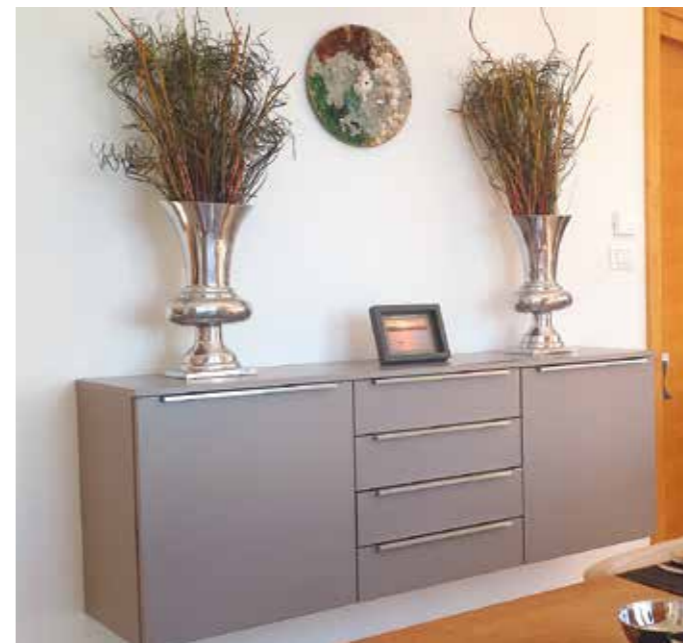
16. ... wird eine durchlaufende Abdeckplatte aufgelegt und von unten verschraubt. Die Optik entspricht der unserer Küchenarbeitsplatte.
