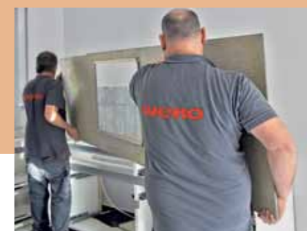
18. Auf der Koch-Küchenzeile liegt eine Keramikplatte mit Ausschnitt für die Glaskeramik.
