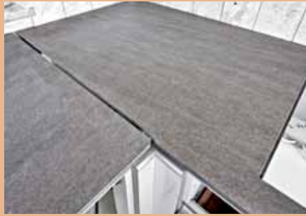
21. Detail-Perfektion: Am 90-Grad-Winkel der U-Küche sind die Stoßkanten exakt zugeformt.
