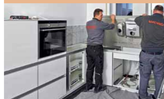
16. Die Spüle besteht aus zwei Unterbaubecken, die einzeln unter der Keramikplatte fixiert sind.
