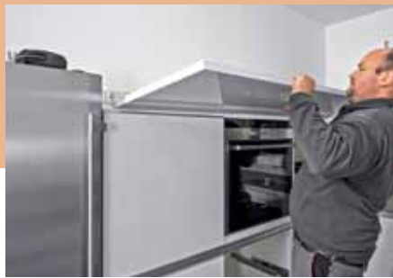
25. ... Korpusse noch mit einer dicken Deckplatte optisch und mechanisch zusammengehalten.
