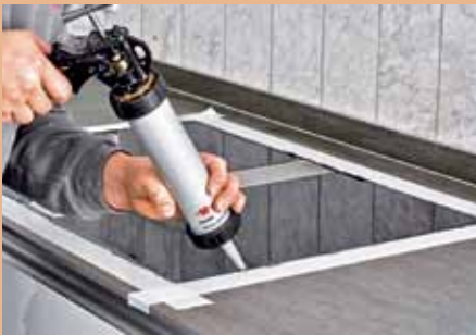
22. Verfugt wurden die Übergänge vom Kochfeld zur Keramikplatte sowie der Wandabschluss.
