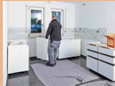
5. Der 60er-Spülenunterschrank passt exakt davor, links davon noch Platz für den Geschirrspüler.
