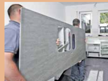
13. Diese sind aus 10 mm dicker Spezialkeramik und wurden bereits mit Ausschnitten versehen.
