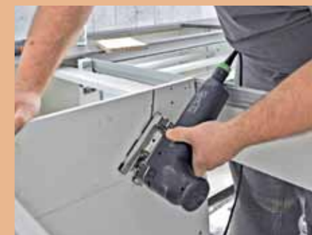
15. ... nach exaktem Ausmessen das Aussägen mit der Stichsäge kein Problem darstellte.
