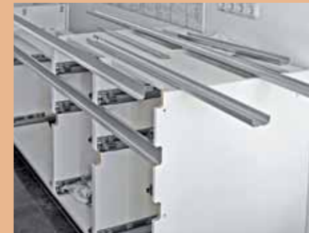
11. ... eingelegt und verschraubt. Darunter das zweite Profil, das ebenfalls bündig abschließt.
