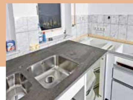
17. Diese Art des Einbaus ist besonders beim Abwischen der Platte im Küchenalltag hilfreich.
