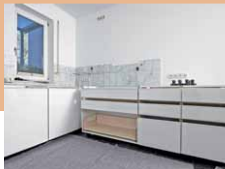
6. Rechts schließt sich das U mit dem Kochfeldunterschrank und zwei Schubladenelementen.
