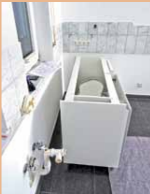
4. Die alten Wasser- und Abwasseranschlüsse sollten und konnten an Ort und Stelle bleiben.
