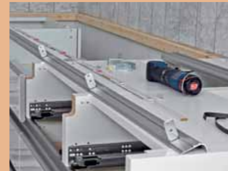
10. Die obere Alu-Leiste ist ein L-Profil und wird in die obere Aussparung der Schrankwände ...
