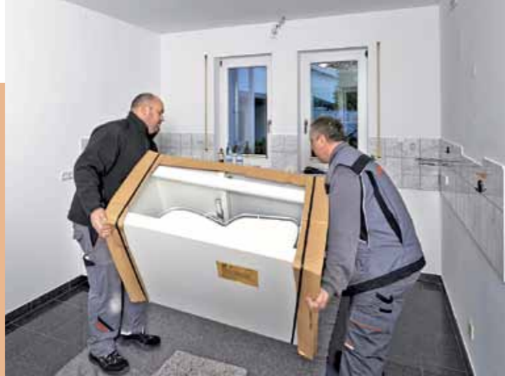
2. Die meisten Möbel sind vormontiert und zum Teil auch schon mit der Innenausstattung bestückt, wie z. B. hier die Eckschränke mit Le-Mans-Auszug.
