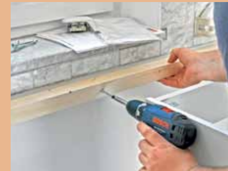
12. Wandseitig wurden dann Hilfskanthölzer verschraubt, die die Abdeckplatten mittragen.
