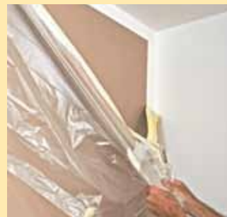
18. Dann lässt sich das Klebeband samt Schutzfolie auch schon abziehen. Ergebnis: Scharfe Trennkante zwischen Farbfläche und Rahmen.
