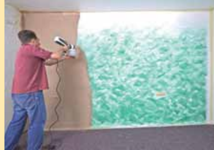
15. Bei gleichmäßigem Vorgehen und Abstand deckt die Farbe nach dem ersten Auftrag super ab. Und die Vernebelung ist kaum spürbar.
