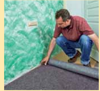
4. Vorsorge für das spätere Farbsprühen: Auch der Boden sollte nahe der Wand geschützt werden.
