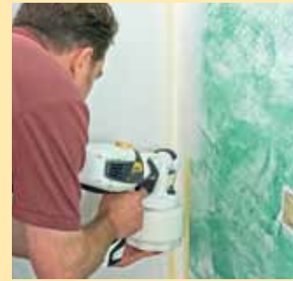
9. Den weißen Rand so sprühen, dass das Klebeband zur Farbfläche hin „versiegelt“ wird. So kann später die neue Farbe nicht eindringen.
