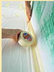
11. ... weiße Rahmen komplett überklebt ist. So bekommt man auch eine akkurate Kante.
