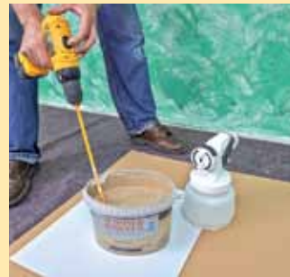
12. Die neue Farbe im Kaffee-Ton wird ebenfalls nicht verdünnt, sondern nur kurz einmal aufgerührt.
