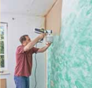
14. Sogleich kann gesprüht werden. Am besten vom oberen Eck aus und von oben nach unten.
