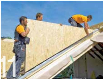
11 Die Gaubenwangen werden per Nut-und-Feder-System auf der Fußbohle platziert.
