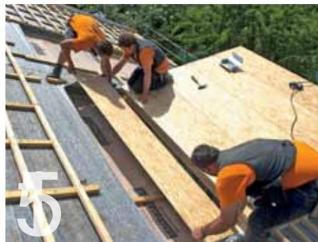
Auch die Dachelemente sind OSB-beplankt. Hier der Anschluss an die Dachschräge.
