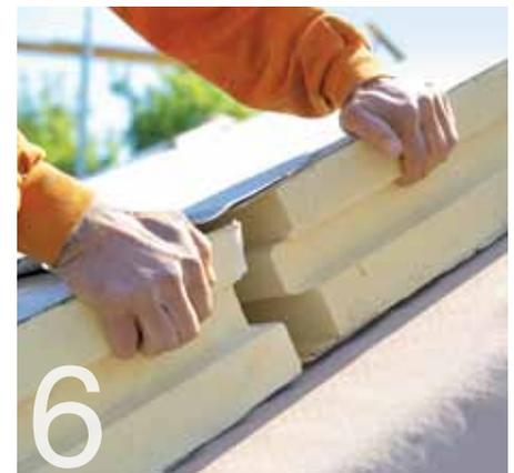
6 ... Unterdeckbahn zeigt nach oben. Die PU-Elemente bilden eine lückenlose Dämmschicht.
