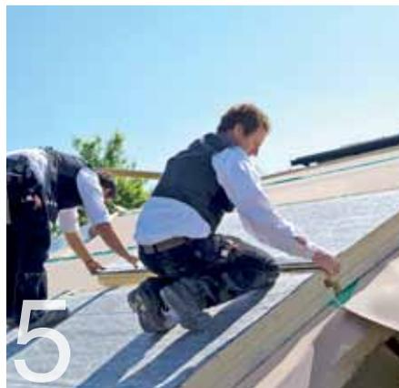
5 Die Dämmelemente werden verlegt: Die Seite der Alu-Kaschierung zeigt nach unten, die ...
