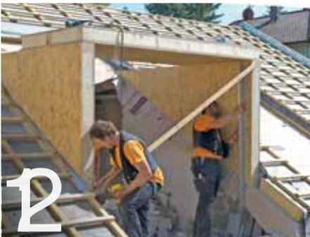
13 Eine Diagonallatte fixiert die Wände, bis diese an den Fußbohlen verschraubt worden sind.
