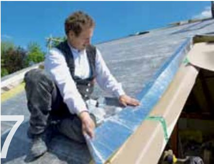
7 Die Dämmelemente werden um die Gaubenöffnungen herum luftdicht abgeklebt. Dann ...
