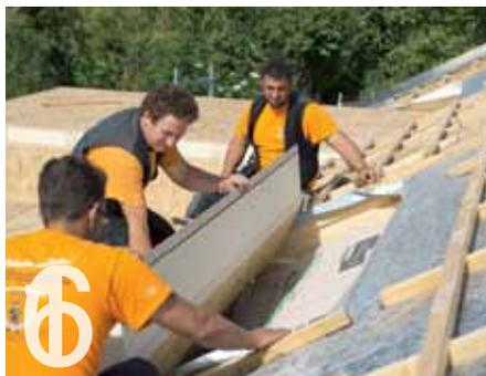
Hier gilt es, die Unterdach-Dichtbahn sowie das Unterdach lückenlos anzuschließen.
