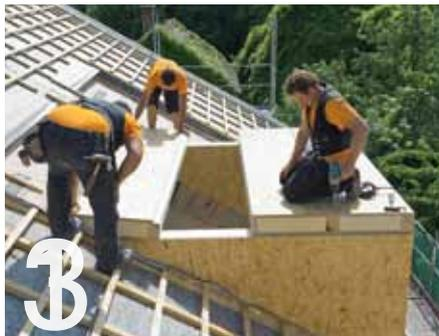
14 Das Dach wird montiert. Es besteht aus mehreren Teilen, die überlappend verlegt werden.
