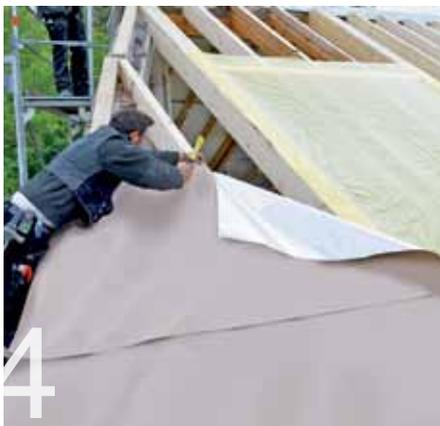
4 Die Luftdichtheitsschicht kommt auf die Sparren – quer verlegt und überlappend verklebt.
